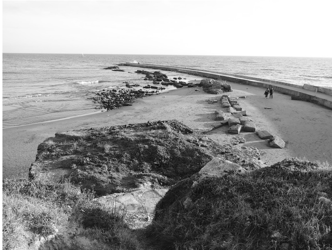
図11：アンティウム港の防波堤の遺跡（筆者撮影）
