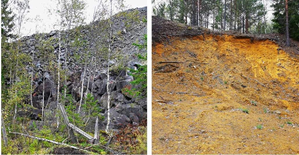
Kuva 6. Vasemmanpuolisessa kuvassa näkyy jyrkkä sivukivikasa Virtasalmen suljetulla kaivosalueella. Oikeanpuolisessa kuvassa on havaittavissa kaivinkoneen jäljet rikastushiekka-alueen patorakenteessa Orijärven kaivoksen kaivannaisjätealueella (© A. Tornivaara).
