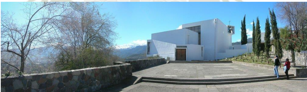
Figura 60: INGRESO DE IGLESIA DEL MONASTERIO BENEDICTINO FUENTE: https://www.archdaily.pe/pe/02-59719/clasicos-de-arquitectura-capilla-del-monasterio-benedictino-gabriel-guarda-martin-correa/pablo_panorama3-2?next_project=no
