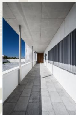
Figura 47: PASILLOS DE HABITACIONES
