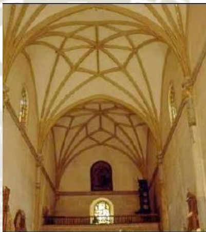
Figura 12: SAN MIGUEL DE HUEJOTZINGO: BÓVEDA DE NERVADURAS FALSAS ARQUITECTURA SIGLO XVI EN MÉXICO” ARQ. CLAUDIA KIYAMA
