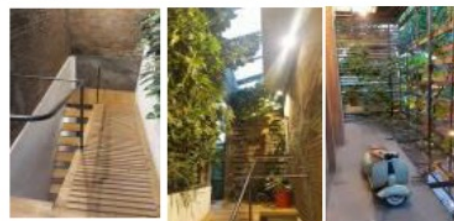
Gambar 14. Penerapan material daur ulang kayu pada tangga, partisi dan sunshading (Survey Lapangan, 2019)
