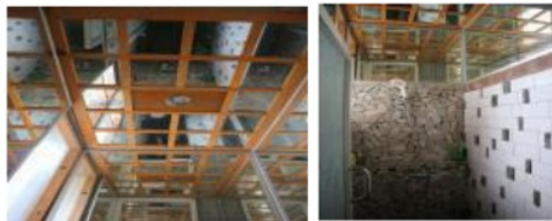
Gambar 8. Penerapan material plafond kombinasi kayu dan kaca (Survey Lapangan, 2019)
