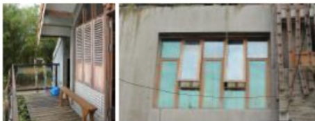
Gambar 12. Penerapan material pada pintu dan jendela (Survey Lapangan, 2019).
