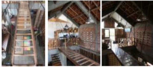
Gambar 4. Penerapan material daur ulang bahan kayu pada jembatan gantung lantai 3 (Survey Lapangan, 2019)
