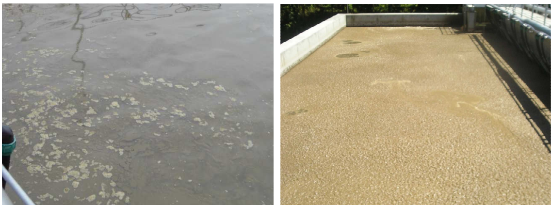
Abb. 5-26: Schlieren auf der Belebung deuten auf unabgebaute lipophile Stoffe hin (links, Foto vom 12.03.2012), Schwimmschlamm mit hohem Fettgehalt (rechts, Foto vom 13.07.2010)
