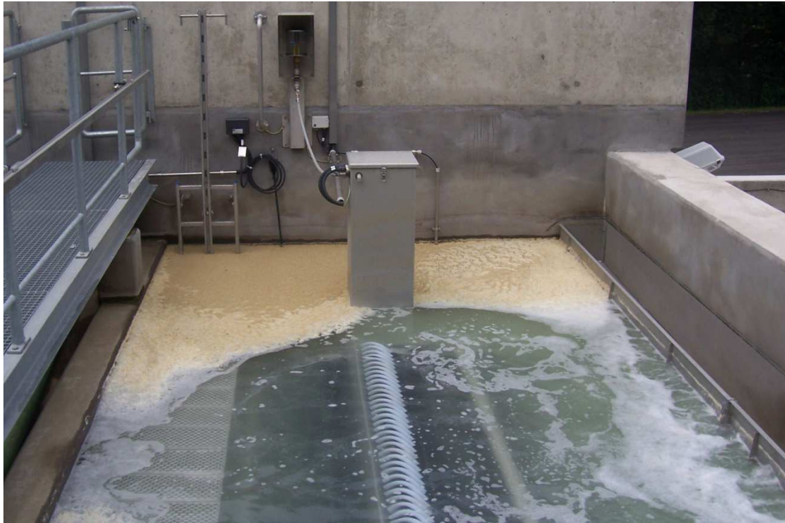
Abb. 4-21: In-situ Hauptreinigung der VRM 3 mit H_2O_2 am 30.07.2009
