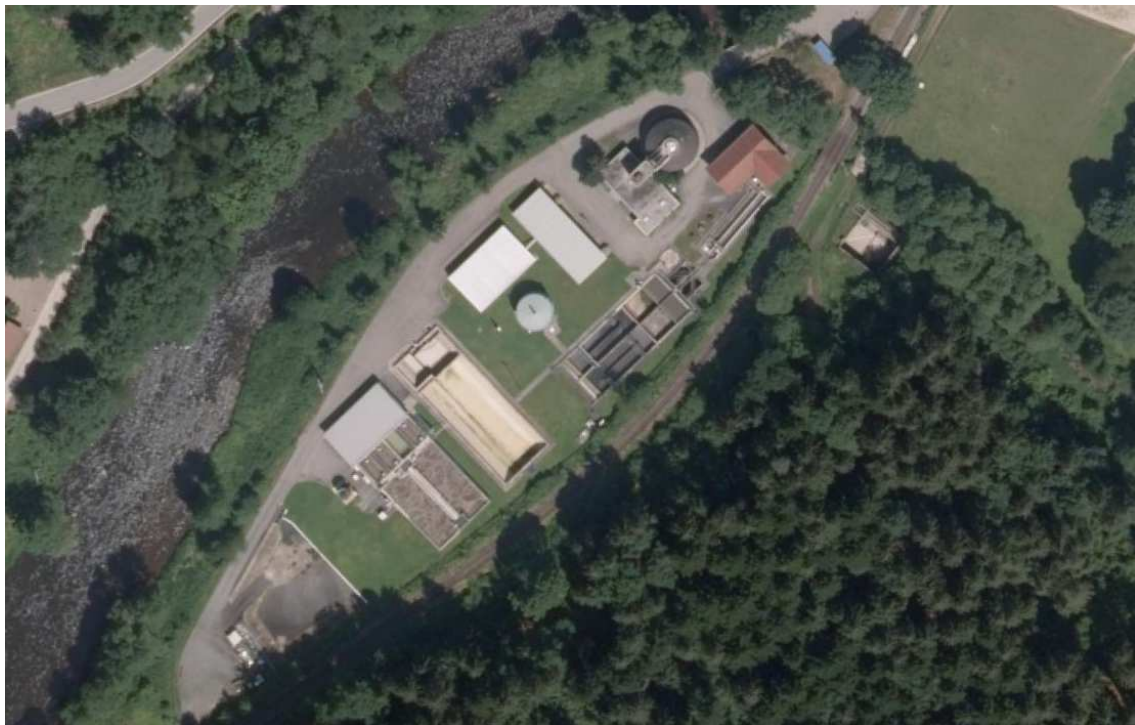
Abb. 3-1: Luftaufnahme KA Hutthurm (Quelle: https://geoportal.bayern.de , Stand 16.11.2018)
