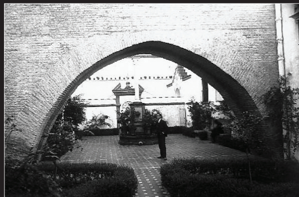
Elementos de arcadas de las Atarazanas insertos en los patios del Hospital de la Caridad.
