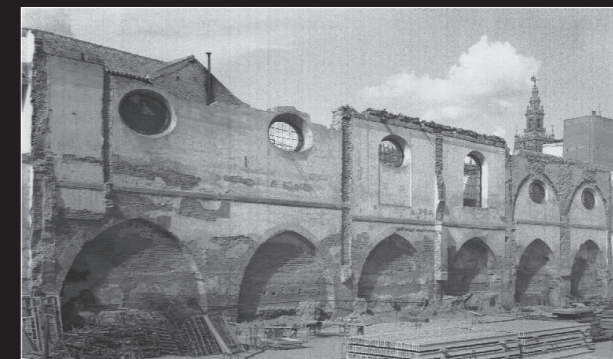
Derribos de las naves del frente sur y los restos de la Aduana en 1942.
