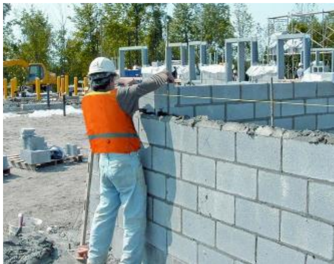
Figura 1: Construcción bloques de concreto
