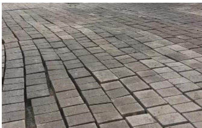
Figura 6: Curado de bloques de concreto artesanal
