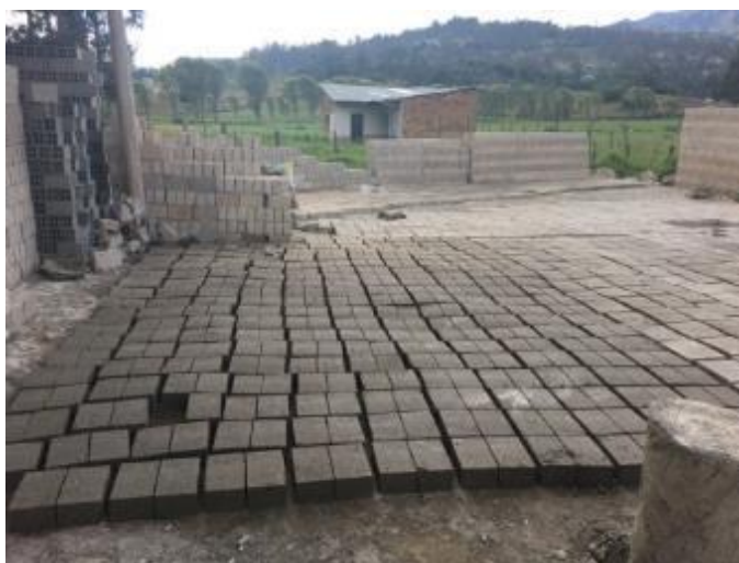
Figura 7: Secado y almacenamiento de ladrillo de concreto artesanal
