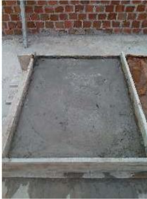
Figura 15: Curado de losa con aditivo.
