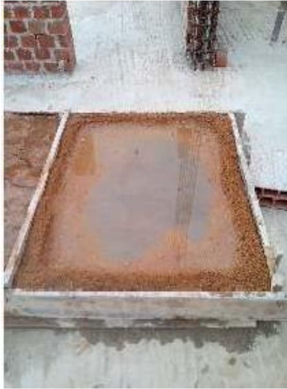
Figura 13: Curado de losa con arena húmeda.
