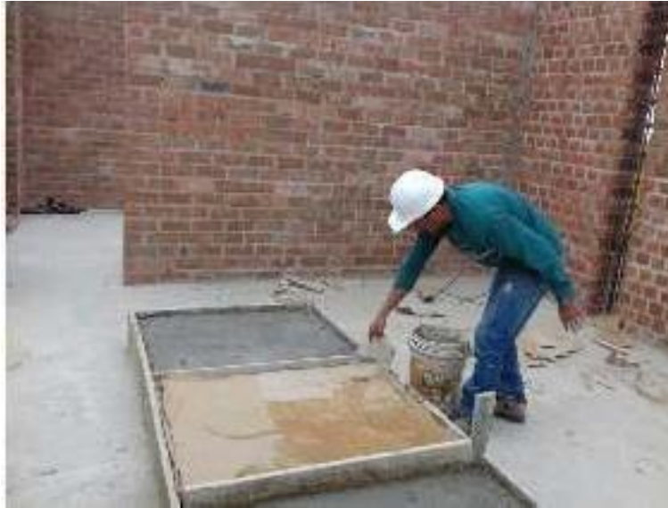
Figura 21: Proceso de curado constante.
