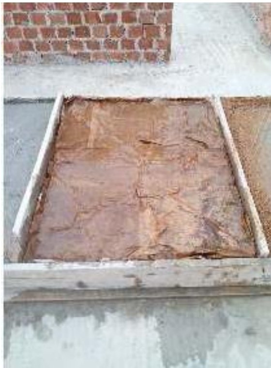
Figura 14: Curado de losa con papel húmedo.
