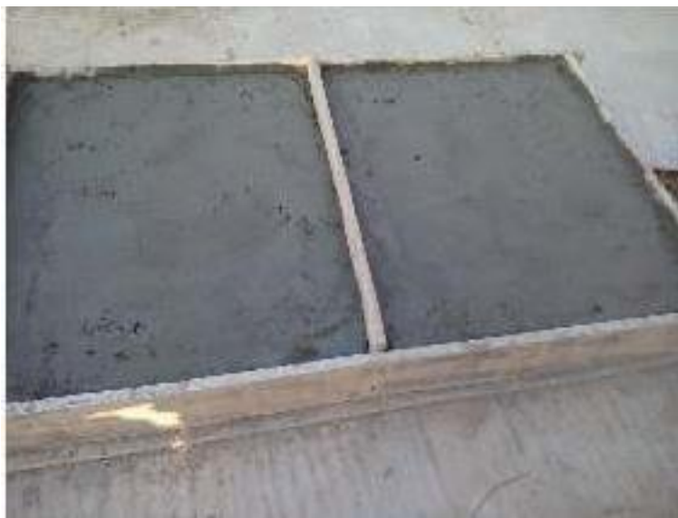
Figura 12: Vaciado de losas a ensayar.
