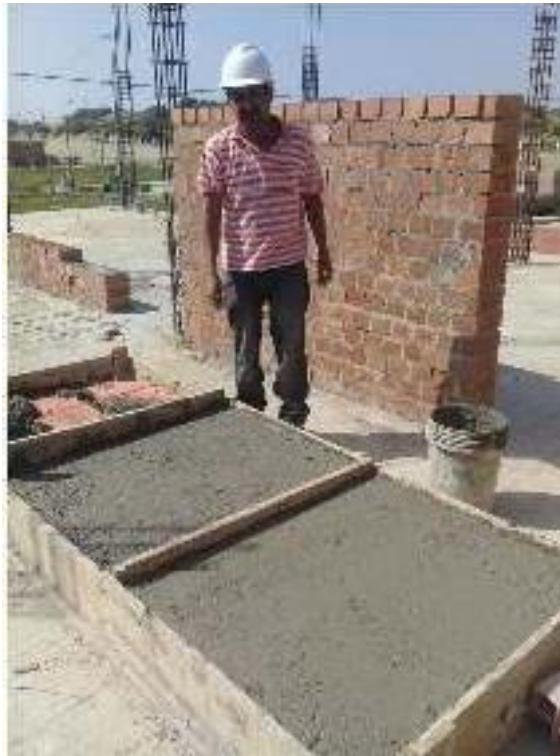
Figura 20: Vaciado y acabado de losas a ensayar.
