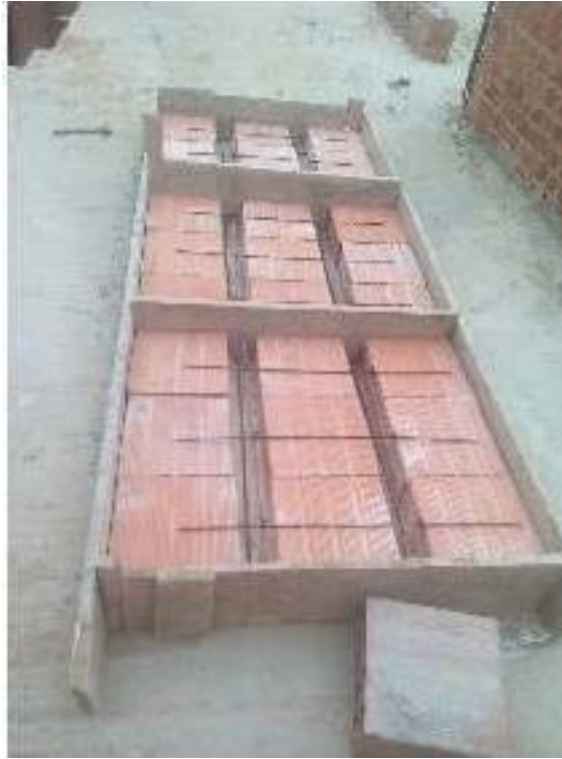
Figura 11: Habilitación de unidades de albañilería y refuerzo para losas a ensayar.
