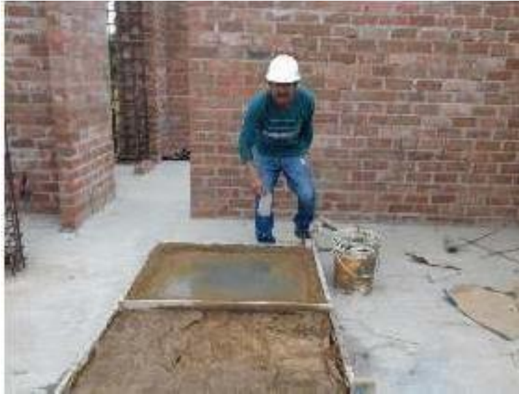
Figura 19: Curado de losas, adicionando agua.
