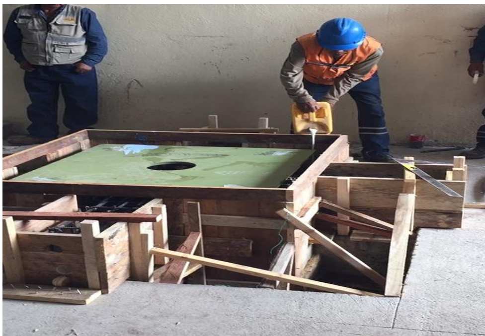
Figura 10. Colocación de placa de apoyo de los aisladores. Fuente: Aguiar (2016)
