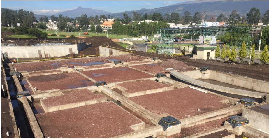
Figura 12. Colocación de aisladores FPS en columnas cortas. Fuente: Aguiar (2016)
