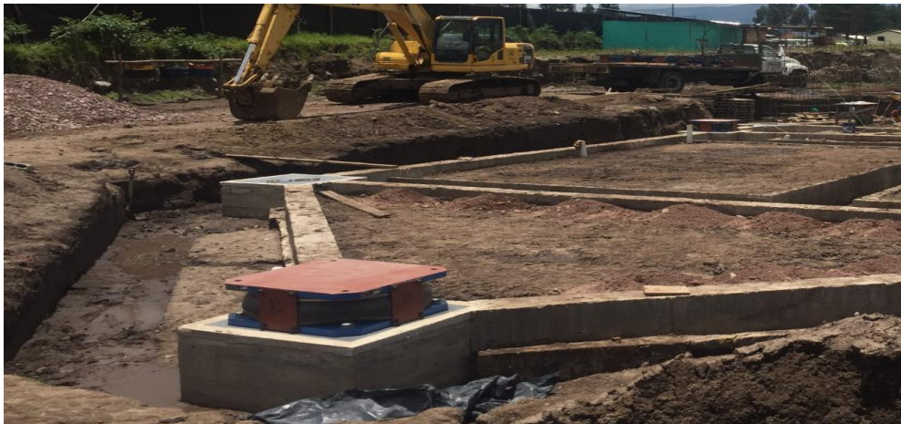
Figura 13. Instalación del aislador FPS. Fuente: Aguiar (2016)
