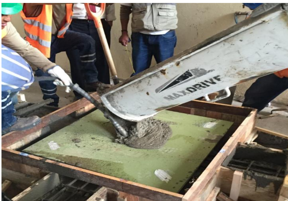
Figura 11. Vaciado del concreto f'c 210 en el pedestal. Fuente: Aguiar (2016)
