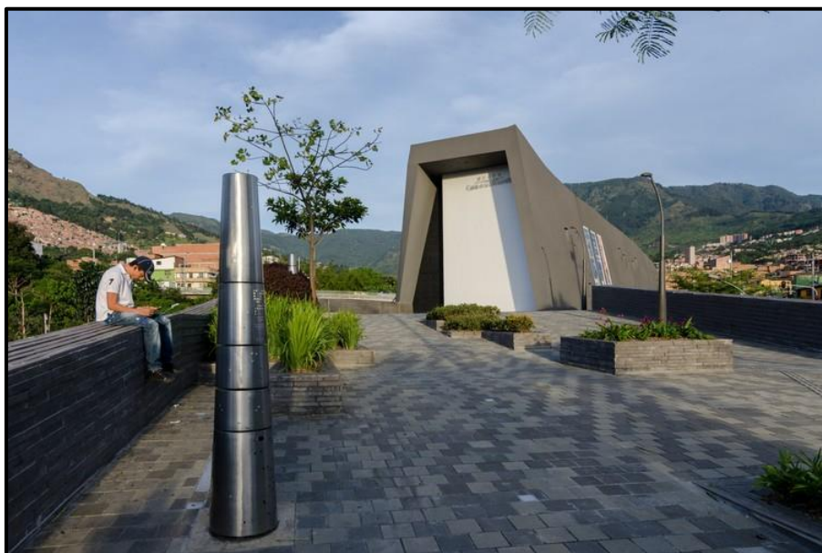
Figura 5. Vista exterior del Museo Casa de la Memoria Fuente: Elaboración propia.
