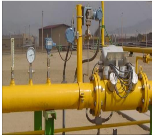
Figura N° 38: Flujo metro Ultrasónico
