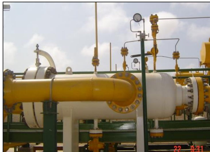
Figura N° 36: Filtro principal de gas natural
