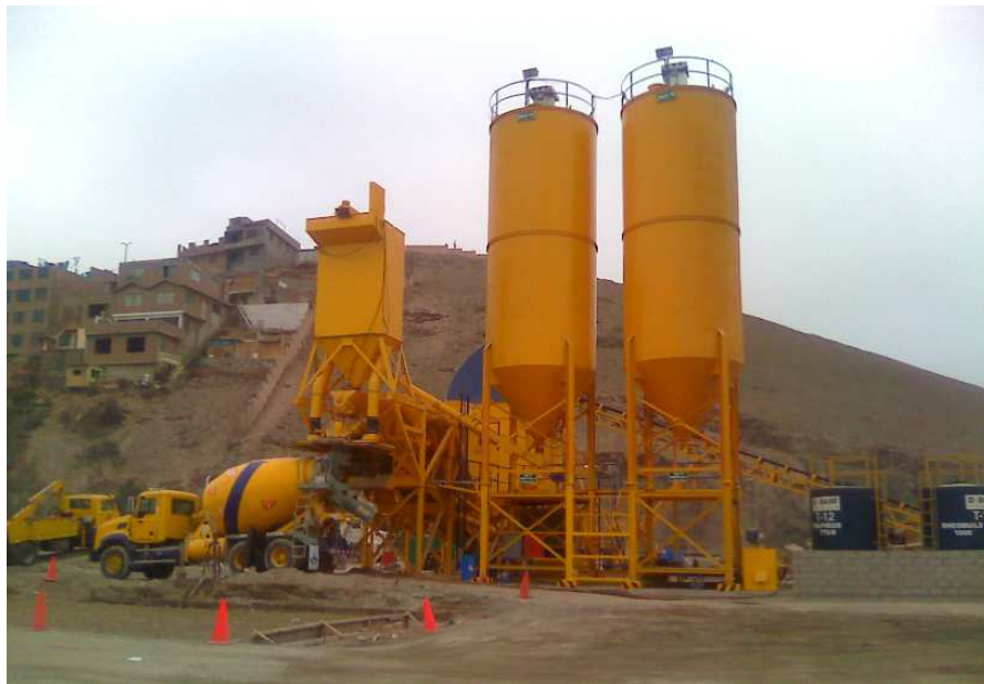
Figura 36. Montaje de Planta Dosificadora en Villa El Salvador - Lima
