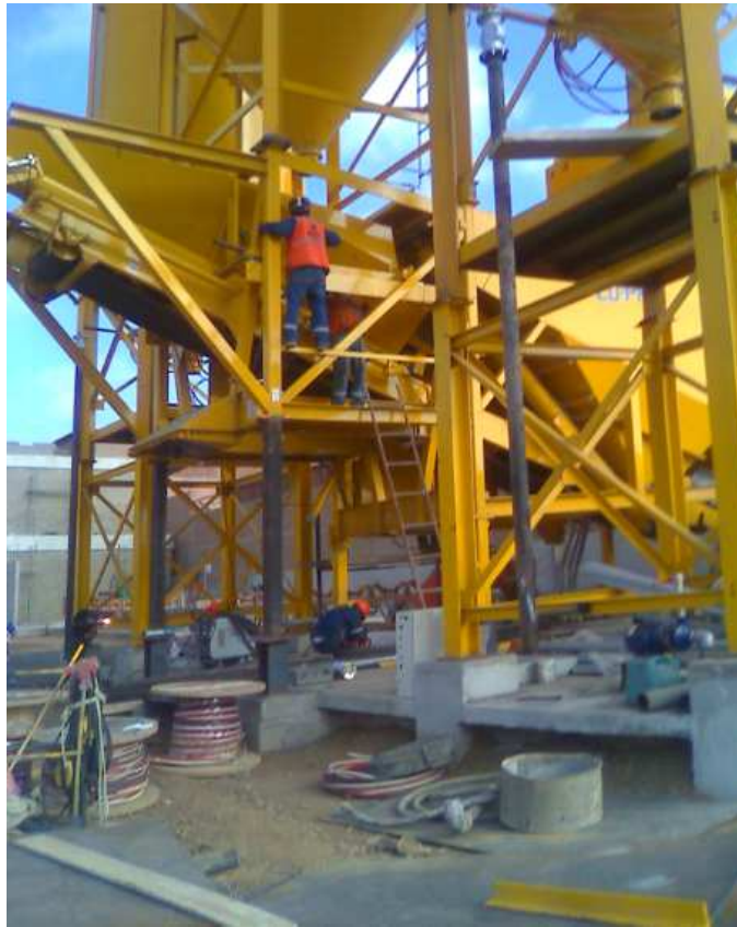
Figura 37. Montaje de Planta Dosificadora en Villa El Salvador - Lima
