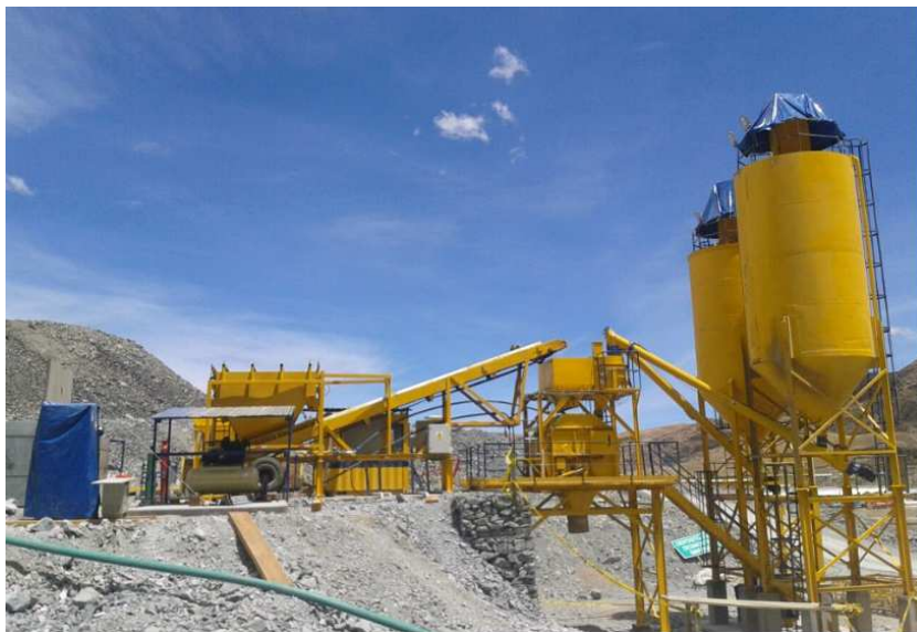
Figura 38. Montaje de Planta Dosificadora en Cerro Lindo - Junín
