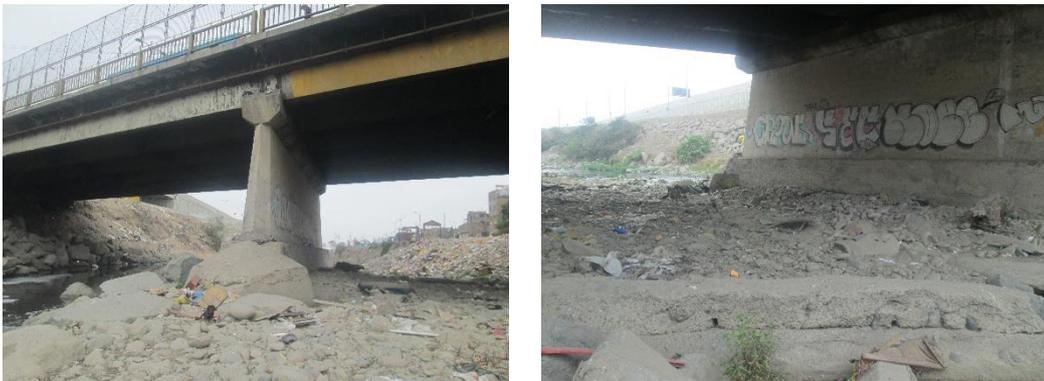
13. **Juntas de expansion** Se observa las juntas de expansion con algunas filtraciones en las partes de los asientos del puente con deformaciones hasta perder algunas partes del elemento.
