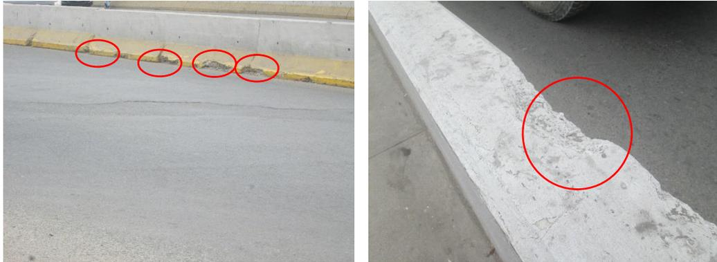
se observa las barreras de concreto con acero de refuerzo expuesto en algunas partes producto de las colisiones de los vehiculos.
