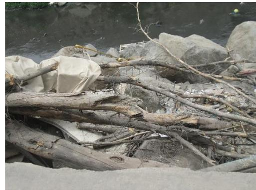
Se observa que los taludes se ha coloca una proteccion de rocas pero presenta erosion considerable en varios tramos.
