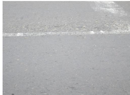
Se observaron grietas en varios tramos del pavimento en forma de red aproximadamente de 5 mm
