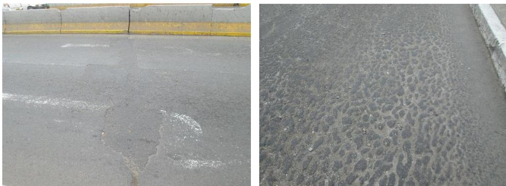
Se observan grietas en red sobre todo resalta una de espesor 3 cm con una longitud de 50 m que practicamente se encuentra en toda la capa asfaltica
