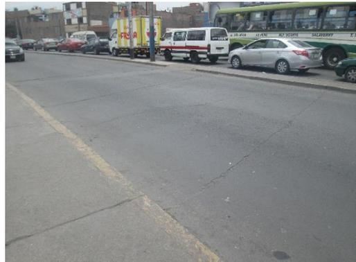
Se observaron surcos con profundidad menor a 2 cm en varias partes de la capa asfaltica del pavimento
