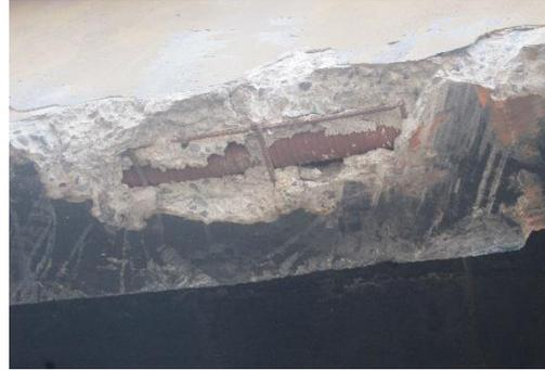
Se observa descascaramiento en algunos tramos de las vigas con eflorescencia en más del 50% de su área
