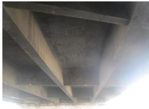
En observa principio de descascaramiento en los extremos de la losa y eflorescencia en mas de la mitad de la losa del puentes.
