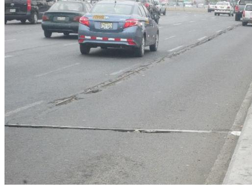
Se observan baches de profundida de 40 mm en varios tramos del pavimento generando congestion vehicular .
