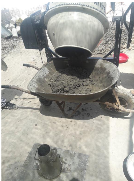
Figura 23. Mezcla para prueba de SLUMP de mezcla.
