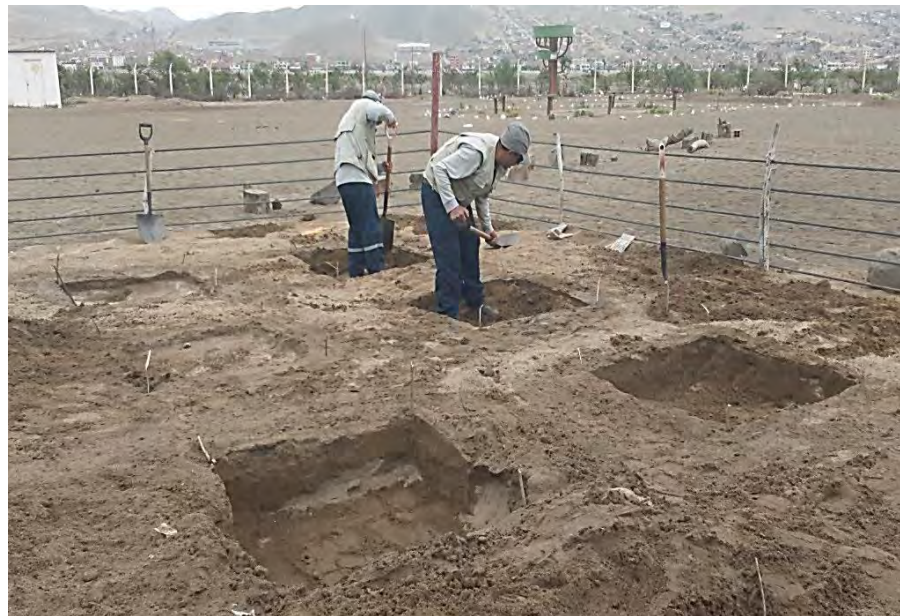
Figura N° 20 Construcción del área experimental.
