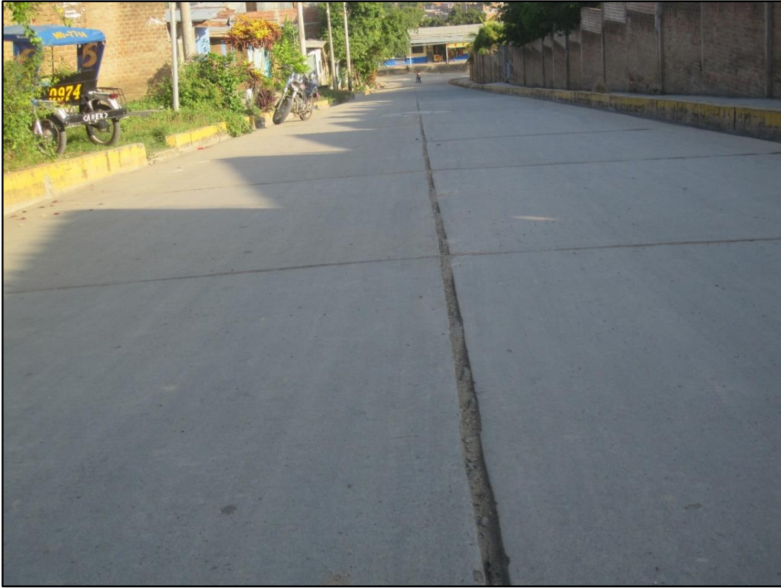
FIGURA N° 27. Vista de vía en estudio. Tramo N° 5.
