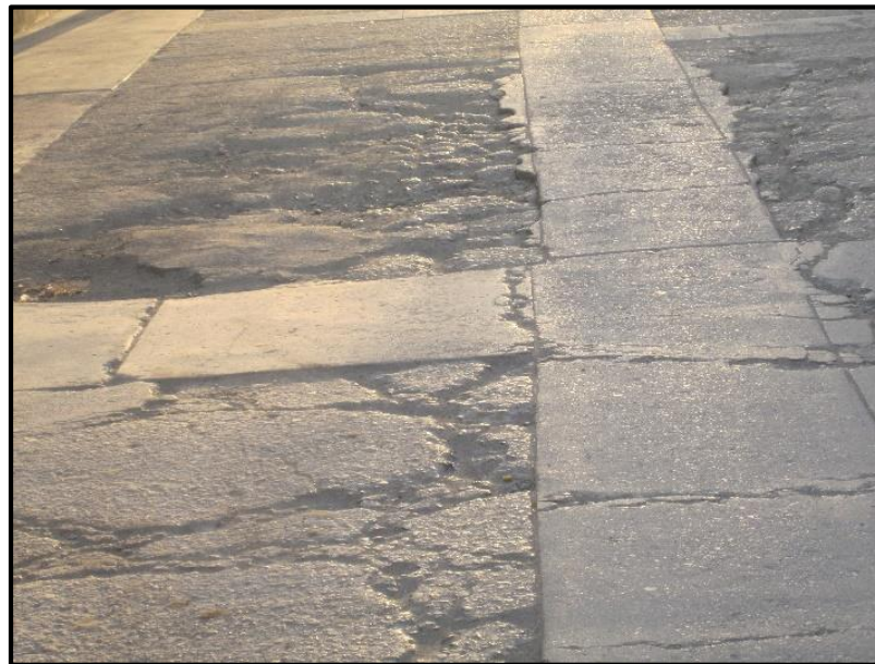
FIGURA N° 10 (LOSAS SUBDIVIDIDAS)
