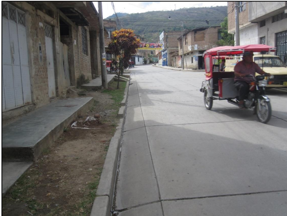
Figura N° 25. Vista de vía en estudio. Tramo N° 4.
