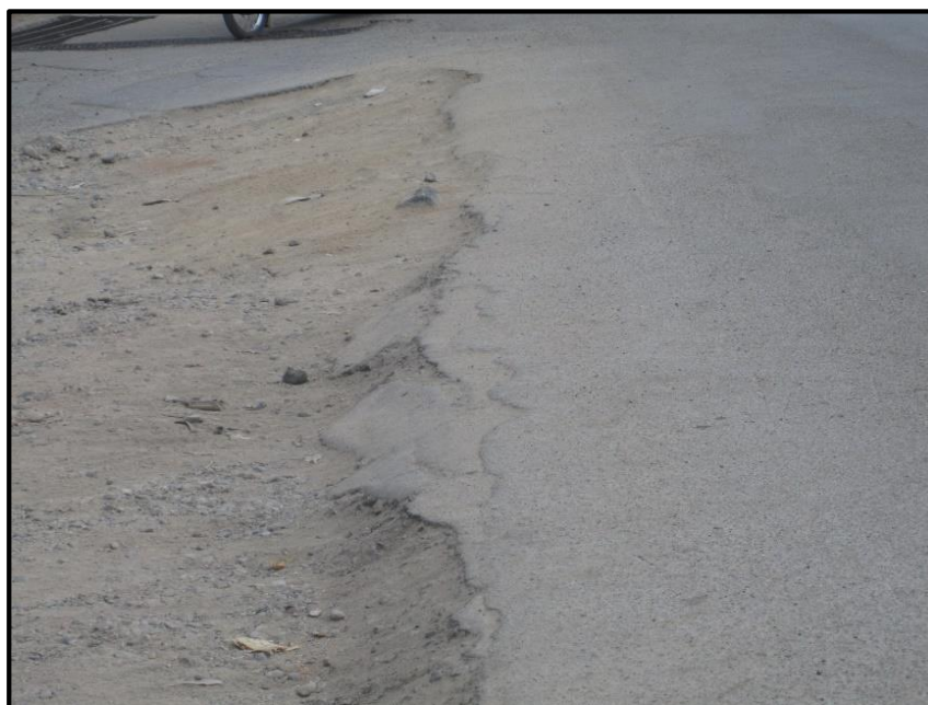
FIGURA N° 04 (EROSIÓN POR BOMBEO)
