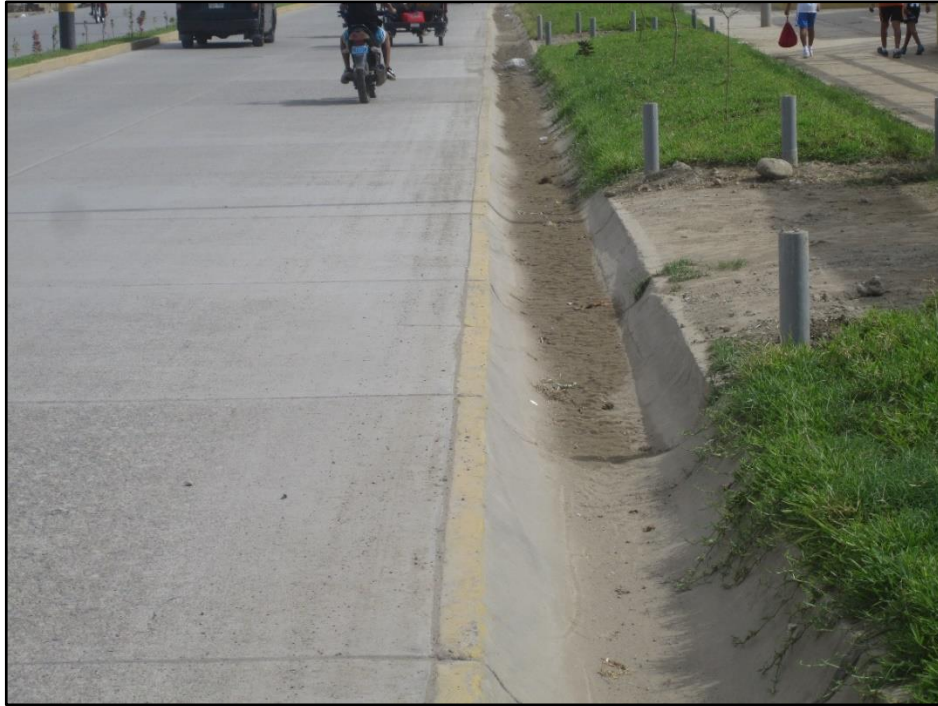
Figura N° 30. Vista de canaleta en drenaje. Tramo N° 5.
