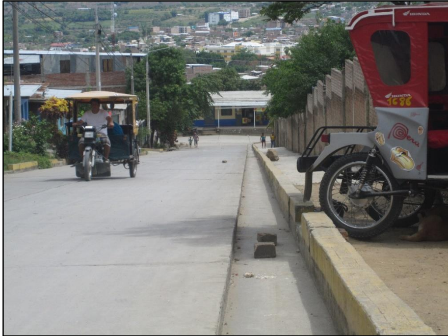
FIGURA N° 19. Vista de vía en estudio. Tramo N° 1.
