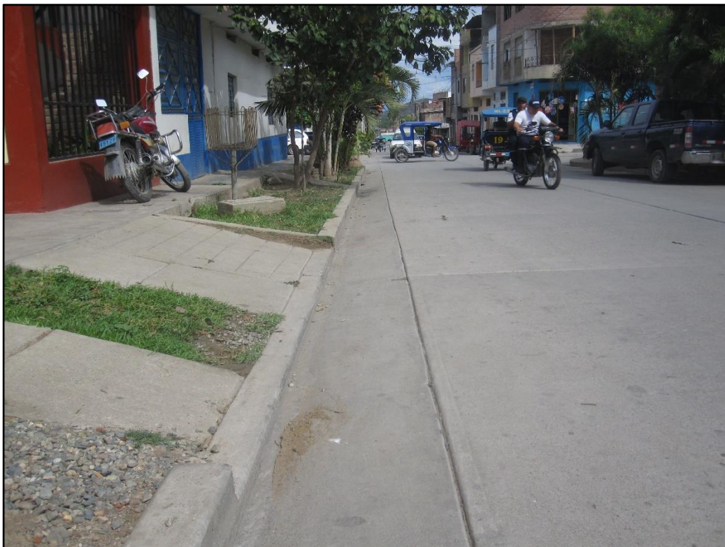
FIGURA N° 21. Vista de vía en estudio. Tramo N° 2.
