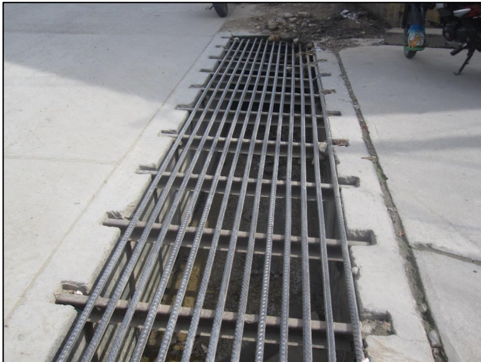
Figura N° 31. Vista de vía en estudio. Tramo N° 1.
