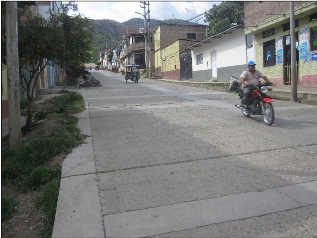
FIGURA N° 23. Vista de vía en estudio. Tramo N° 3.
