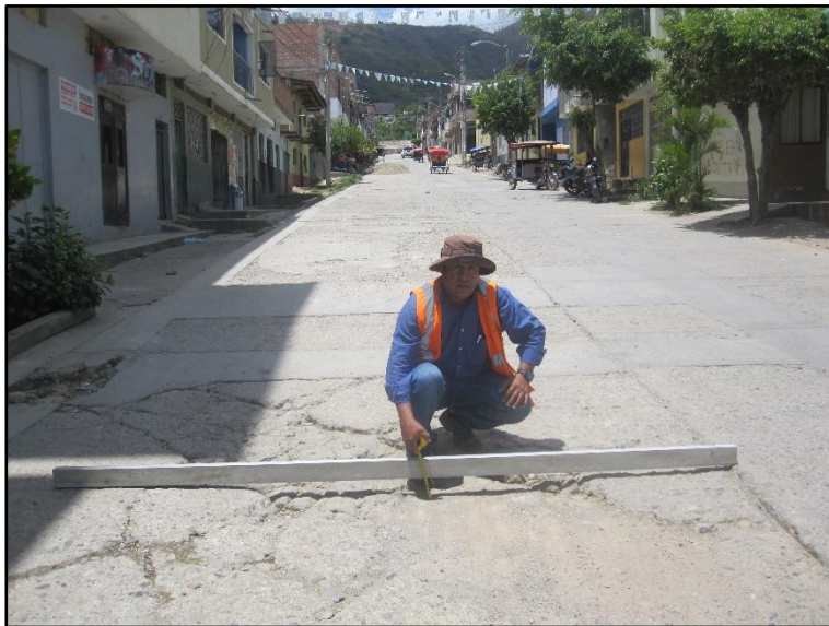
FIGURA: 12 (HUNDIMIENTO)
