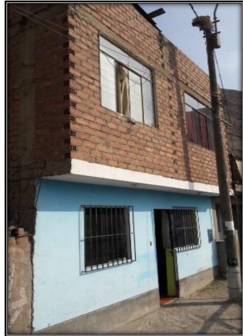
Figura 19: Muros portante con ladrillos pandereta
