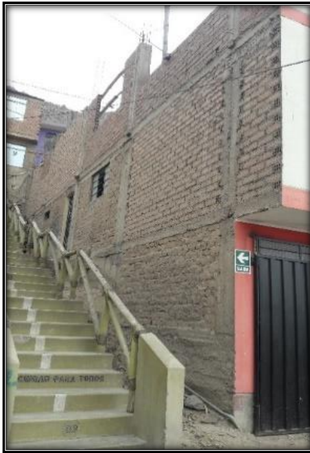
Figura 19: Muros portante con ladrillos pandereta
