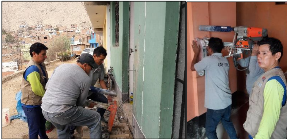
Figura 27: Colocación y sujeción en la columna del equipo perforador
