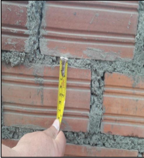
Medición de las juntas menores a 1 cm
