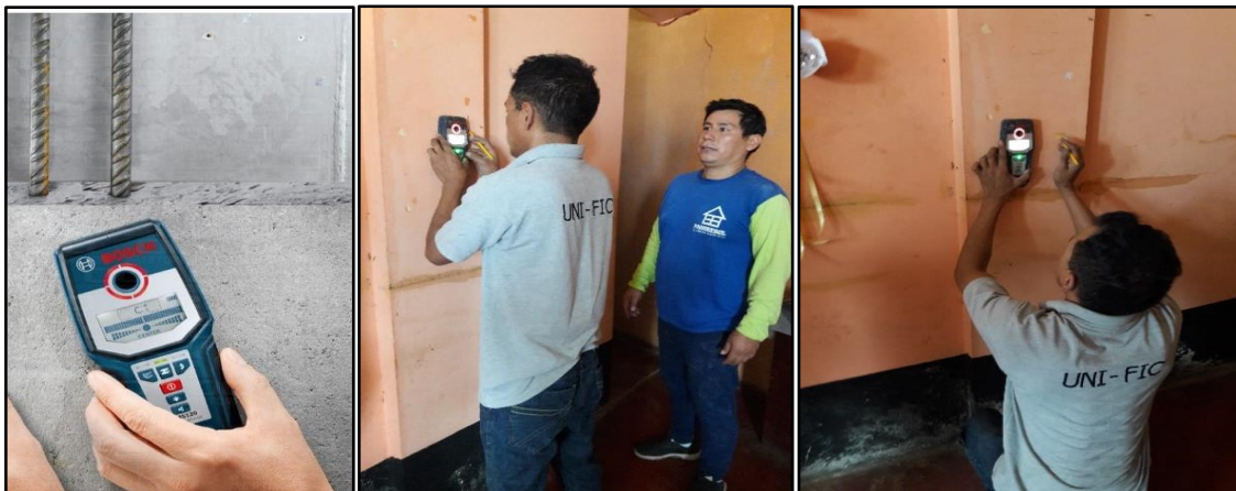
Figura 26: detección del acero en las columnas
