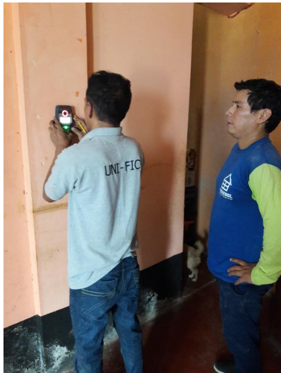
Extracción de diamantinas en la vivienda F-3
