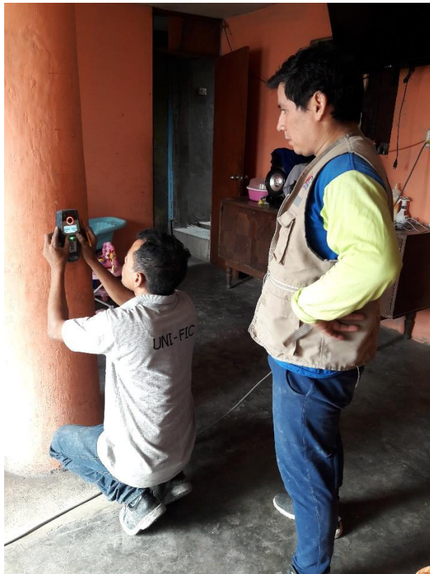
Extracción de diamantinas en la vivienda C-2
