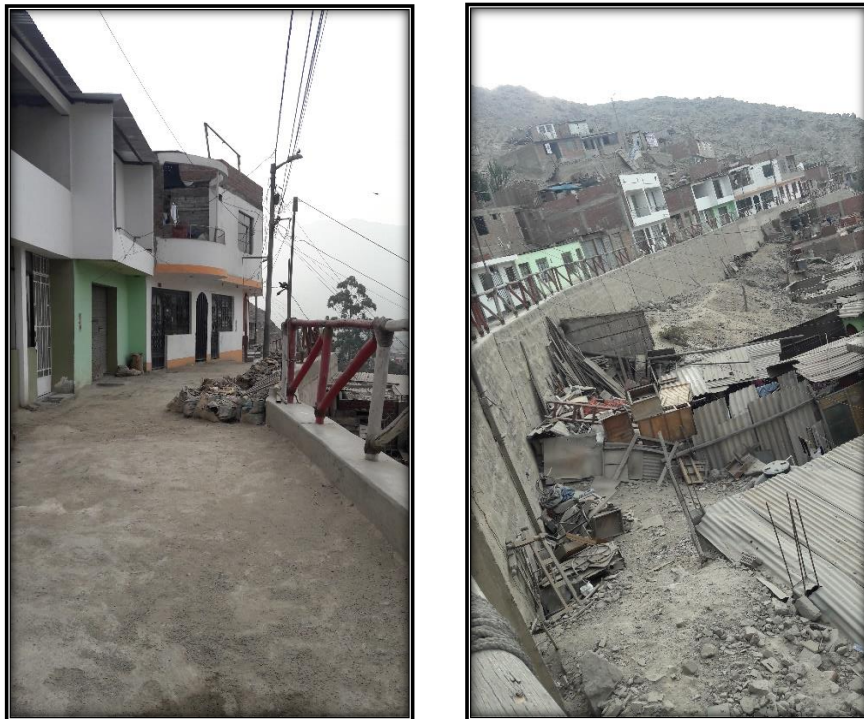
Figura 18: Viviendas sobre relleno formando sus calles principales con el sostén del muro de contención
