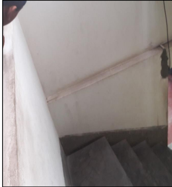
Estructura de la escalera.
