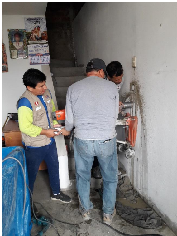
Extracción de diamantinas en la vivienda F-5
