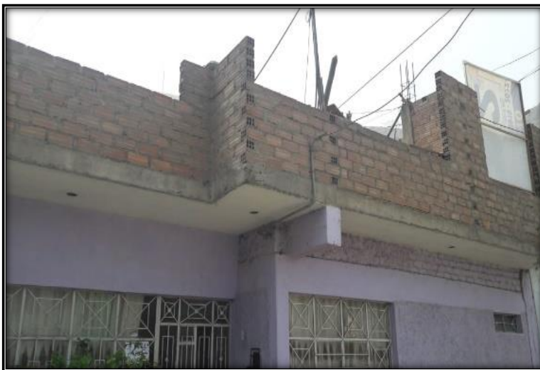
Figura 20: Muros sin confinamiento
