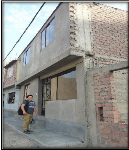
Figura 21: Muro sin vigas en el segundo piso
