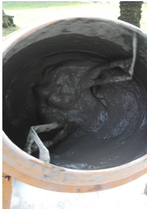
Figura 100. Mezcla de mortero en trompo eléctrico
