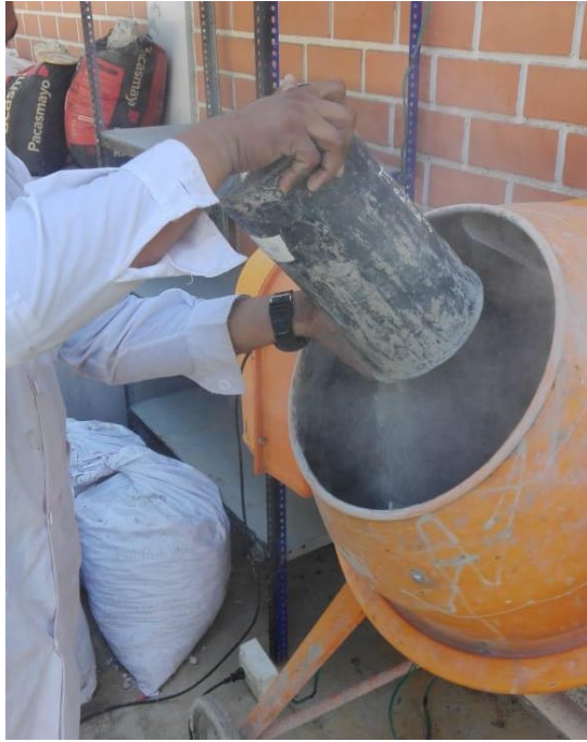
Figura 99. Colocación de materiales para la mezcla de mortero
