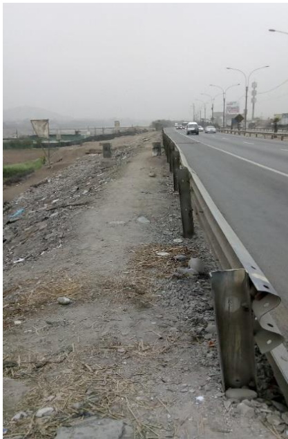
Figura 8: Barrera sin separador
