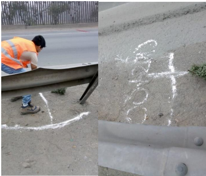
Figura 15: Cota 00+270, deformación por impacto
