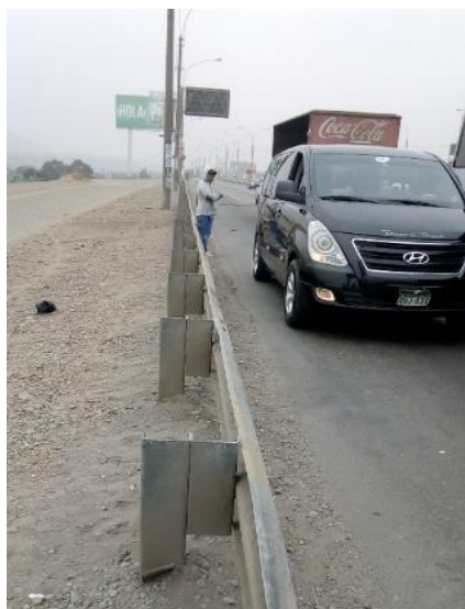
Figura 6:Postes del sistema de contención
