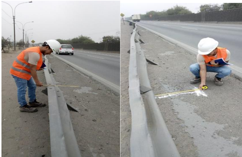
Figura 9: Deformación de la barrera
