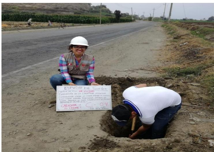
**Fotos 25:** Excavación de calicatas en la progresiva 2+000
