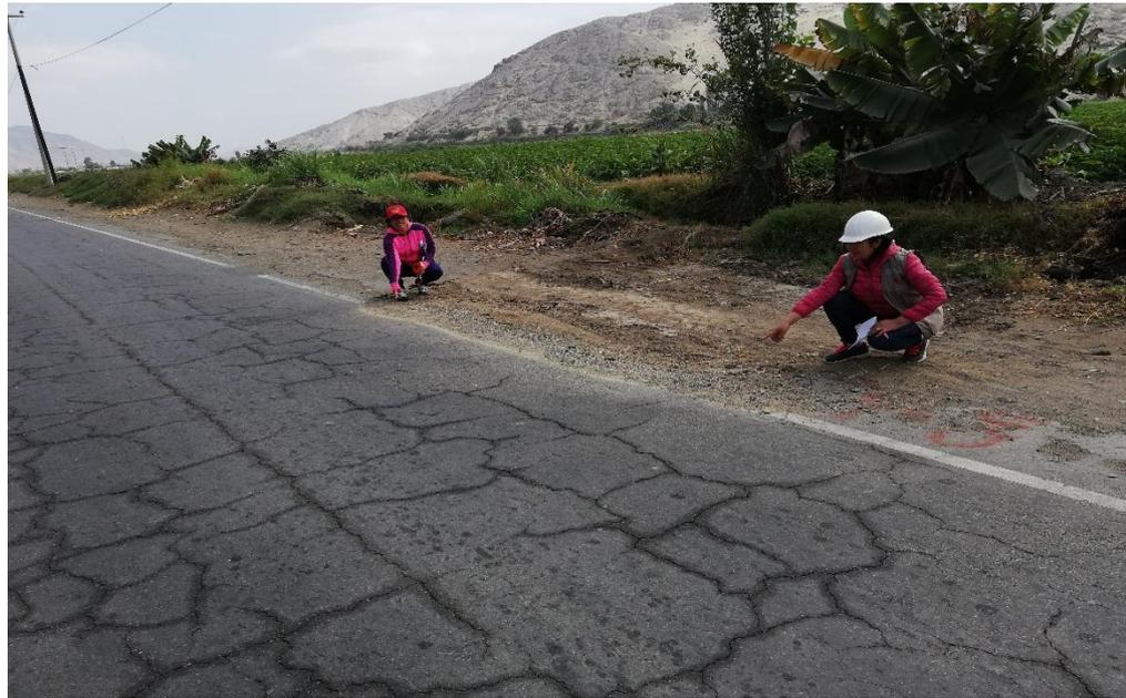
**Foto 05:** Se realizó la medición de las fallas de fisuras de borde
