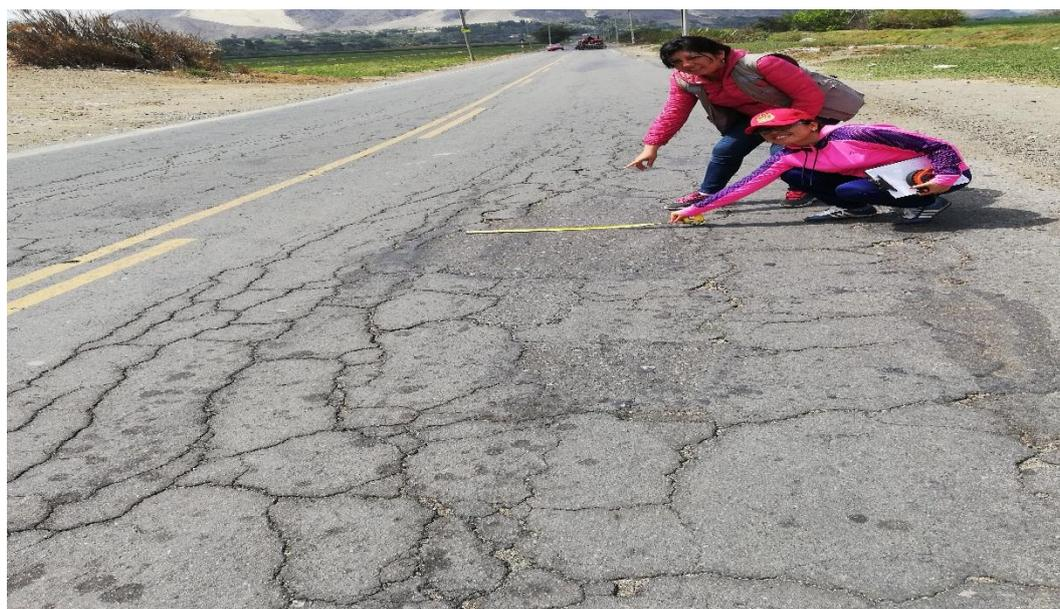
**Foto 02:** Se realizó la medición de las fallas de depresión.
