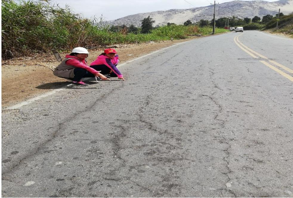
**Foto 03:** Se realizó la medición de las fallas de fisuras longitudinales
