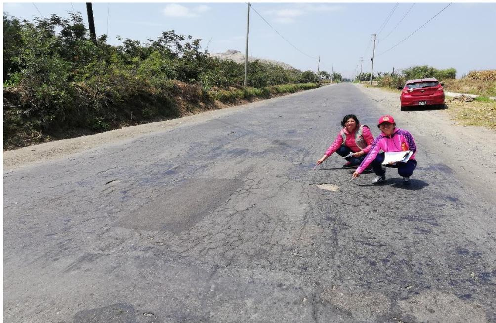
**Foto 06:** Se realizó la medición de las fallas de baches
