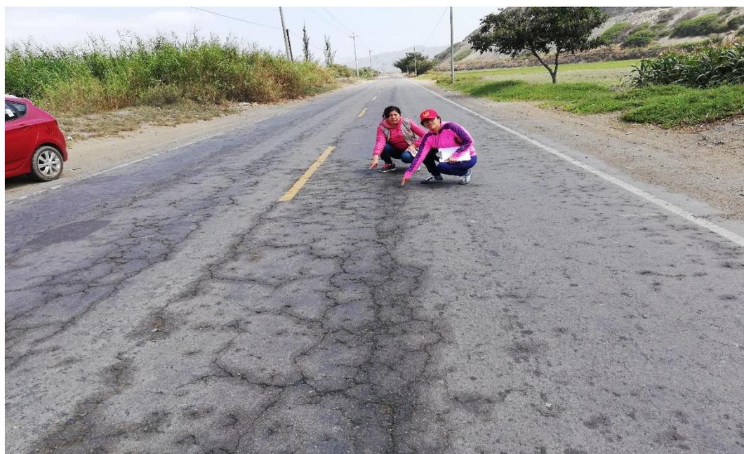
**Foto 08:** Se realizó la medición de las fallas de Piel de cocodrilo.
