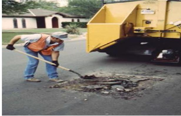
**Figura N°2** Demarcacion y corte de área a reparar
