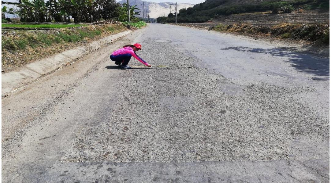
**Foto 09:** Se realizó la medición de las fallas de Agregado Pulido.
