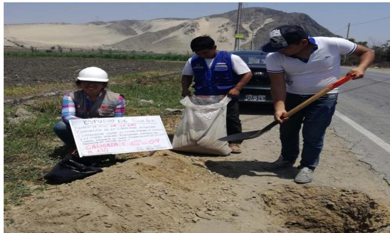
**Fotos 31:** Se procedió a excavar la calicata en la progresiva 4+500, se aprecia extrayendo muestra para el tercer CBR.
