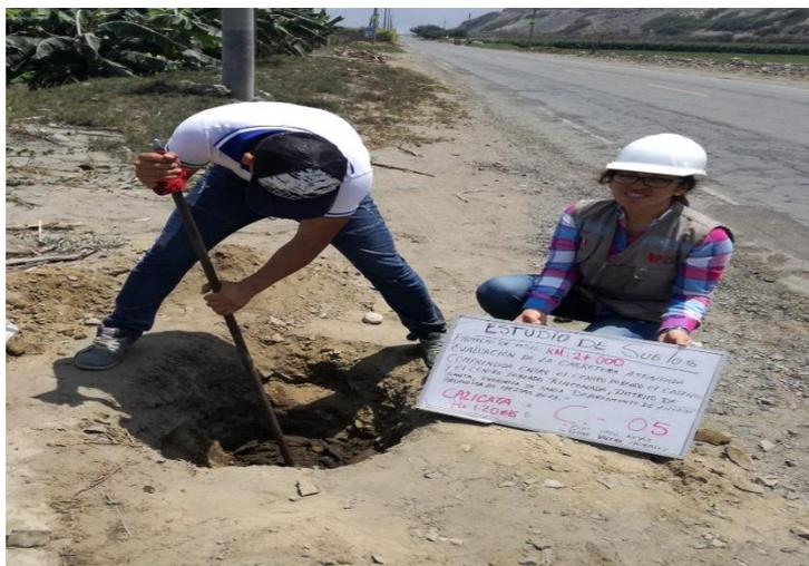
**Fotos 26:** Excavación de calicatas en la progresiva 2+500
