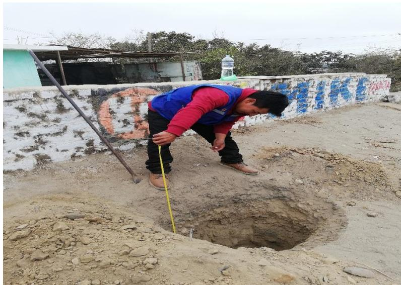
**Fotos 21:** Se procedió a medir las capas que forman el Pavimento flexible
