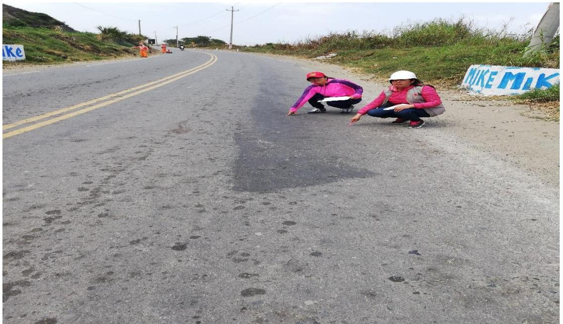
**Foto 10:** Se realizó las medición de las fallas de exudación.
