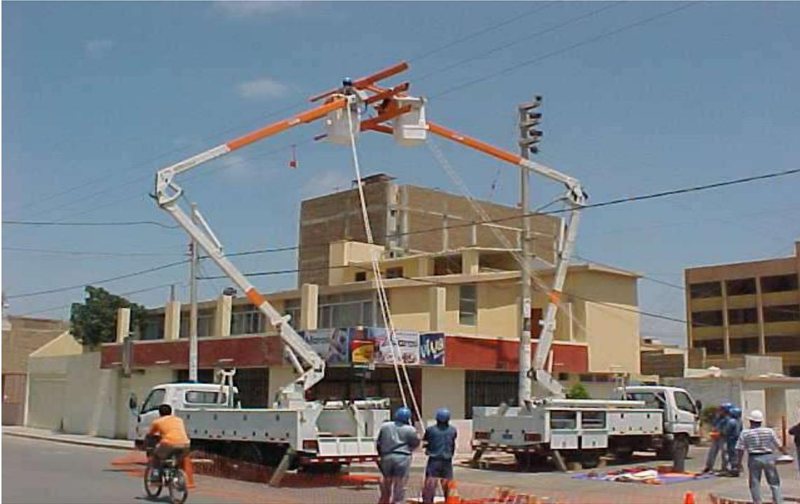
**CAMBIO DE CONECTOR EN DERIVACION EN T CON DOS UNIDADES DE LINEAS ENERGIZADAS**
