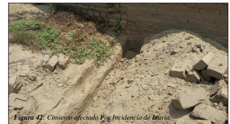
Figura 42: Cimiento afectado Por Incidencia de Lluvia
