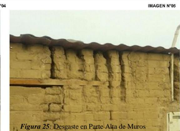
Figura 25: Desgaste en Parte Alta de Muros
