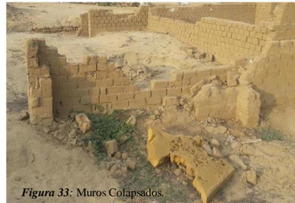
Figura 33: Muros Colapsados.
