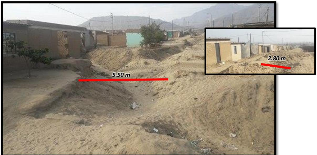
**Figura 222:** Se aprecia que la Calle N°1 presenta afectación en su sección central de 5.50 m en la parte más alta y 2.80 m en la parte más baja.
