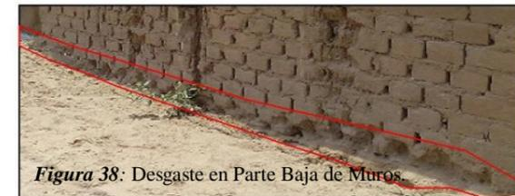
Figura 38: Desgaste en Parte Baja de Muros.
