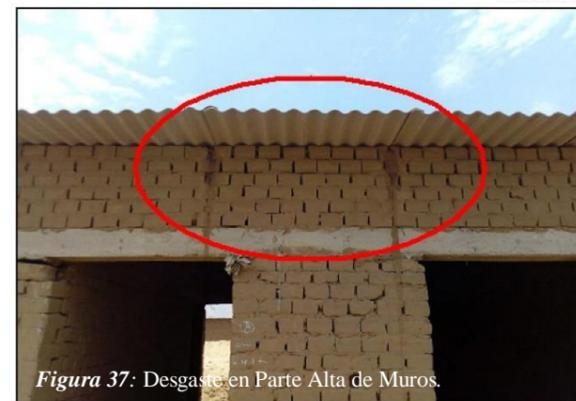
Figura 37: Desgaste en Parte Alta de Muros.
