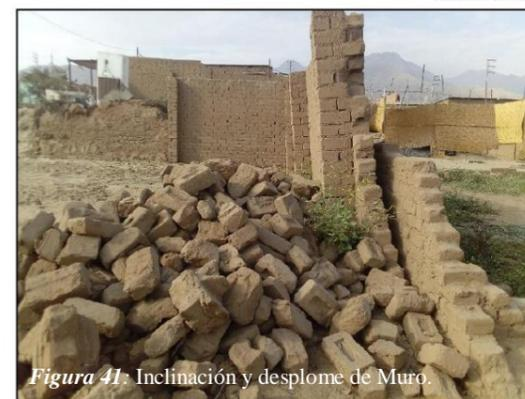
Figura 41: Inclinación y desplome de Muro.
