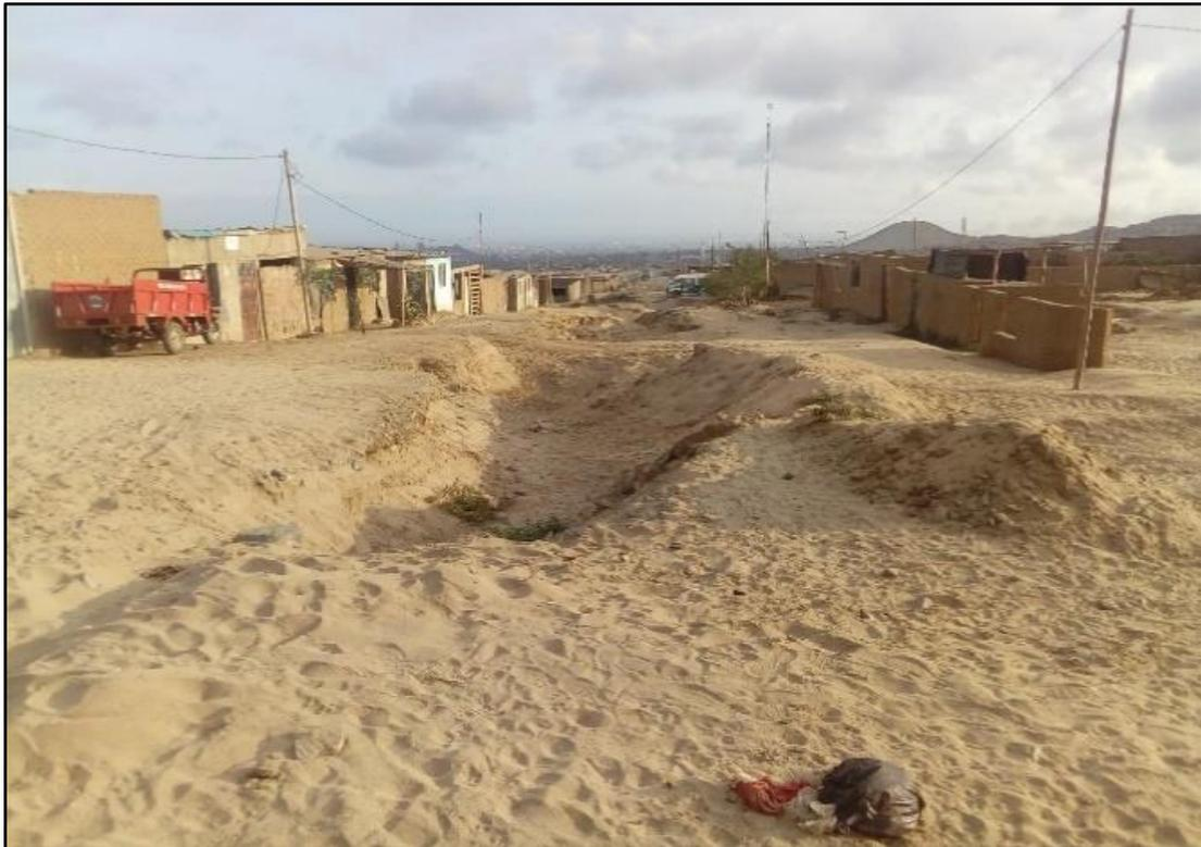
**Figura 220:** Calle N°1 Cuadra 16- Afectada, donde se observa la formación de un canal por discurrimiento de agua
