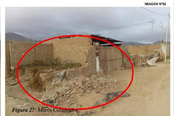
Figura 27: Muros Colapsados.
