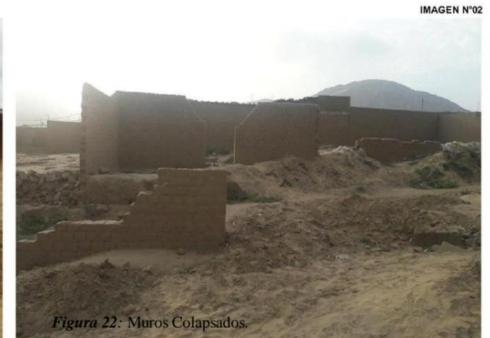
Figura 22: Muros Colapsados.
