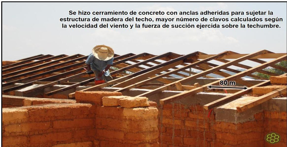
**Figura 100:** Anclaje de cubierta a viga solera -Fuente: Web – Cooperación Comunitaria 2014
