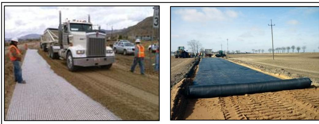
**Figura 160:** Malla Geotextil.
