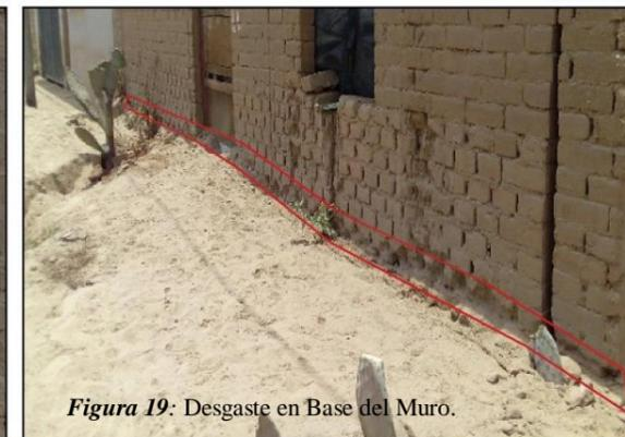
Figura 19: Desgaste en Base del Muro.
