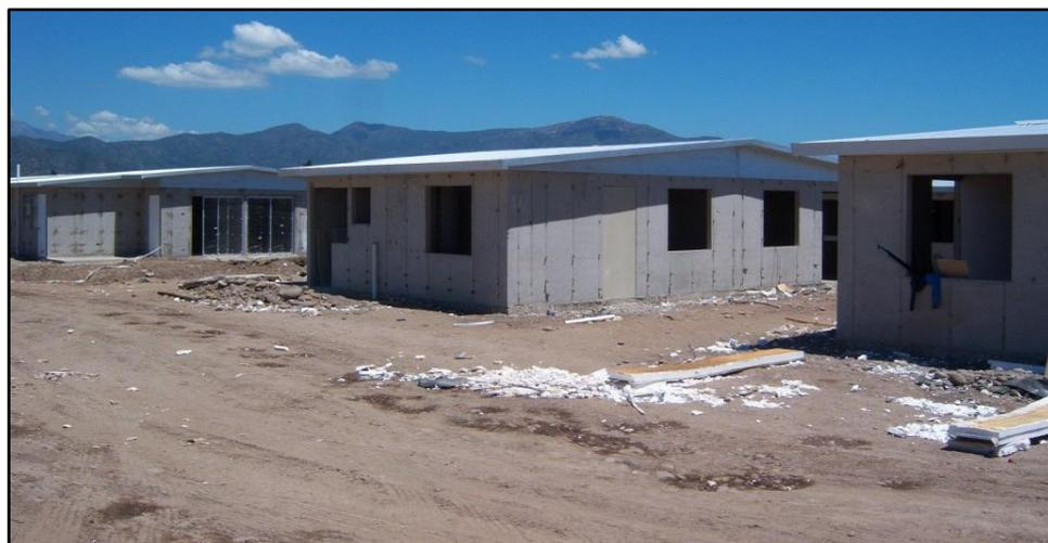
**Figura 146:** Sistema monolítico de concreto armado prefabricado.
