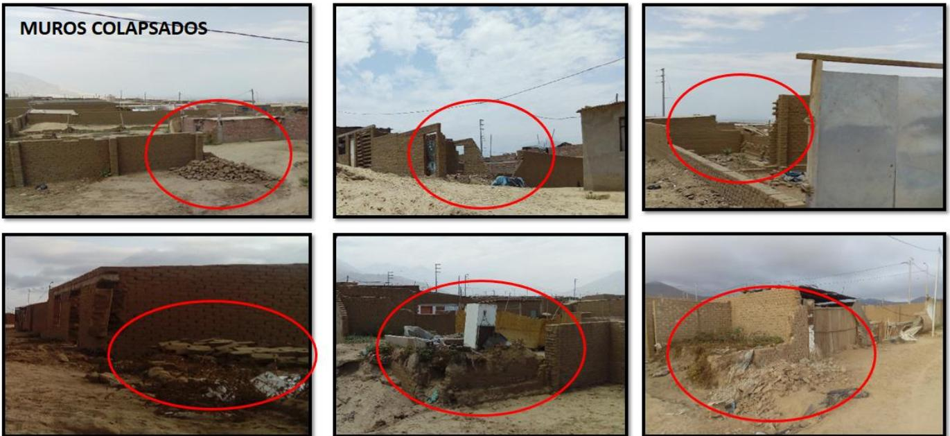
**Figura 229:** 10.1 Los muros de muchas viviendas no resistieron al paso del agua y la lluvia por lo que cedieron y terminaron por colapsar.
