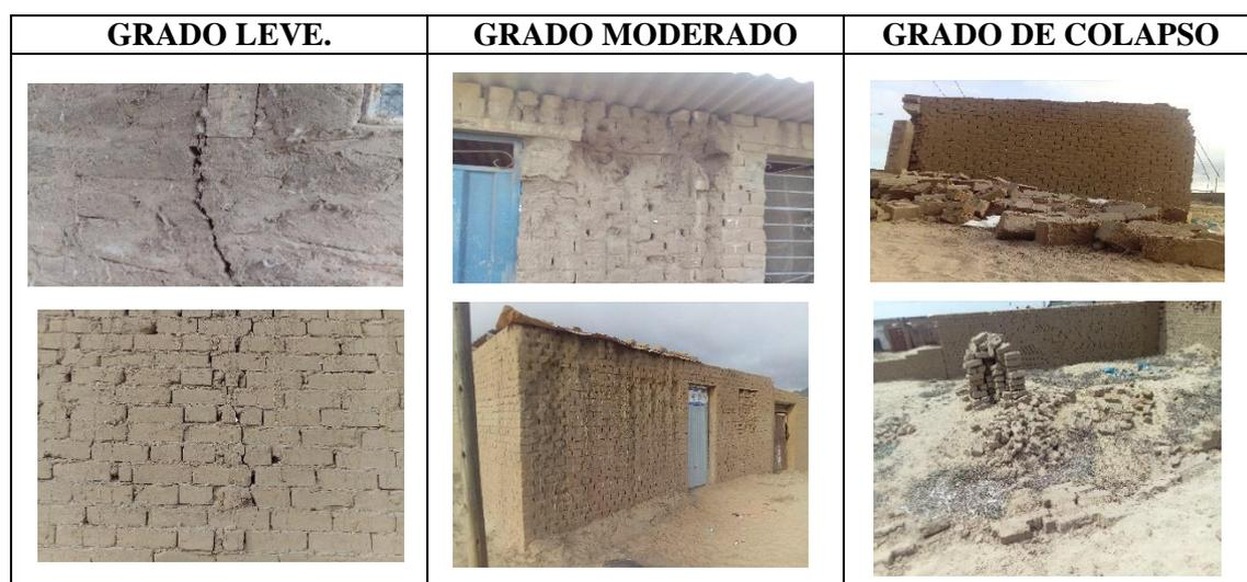
**Figura 111:** Clasificación según grado de Afectación en Viviendas
