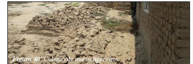
Colapso total de los muros interiores de la vivienda
