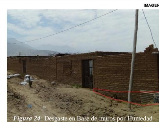
Figura 24: Desgaste en Base de muros por Humedad
