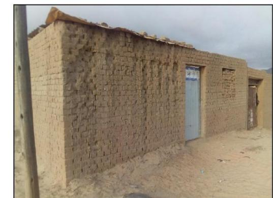
Figura 114: Desgaste por incidencia de Lluvia.
