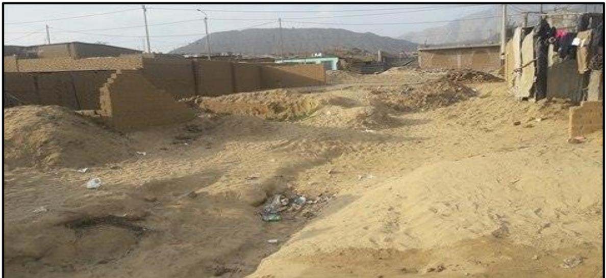
**Figura 226:** Se puede apreciar la profundidad de 1.10m que formo el discurrimiento de agua en la parte más del barrio 6 en la calle N° 1. 7.1 - 7.2 y 7.3 se aprecia las manzanas afectadas.
