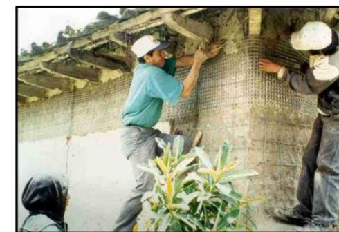
Figura 78: Reforzamiento de Muros.
