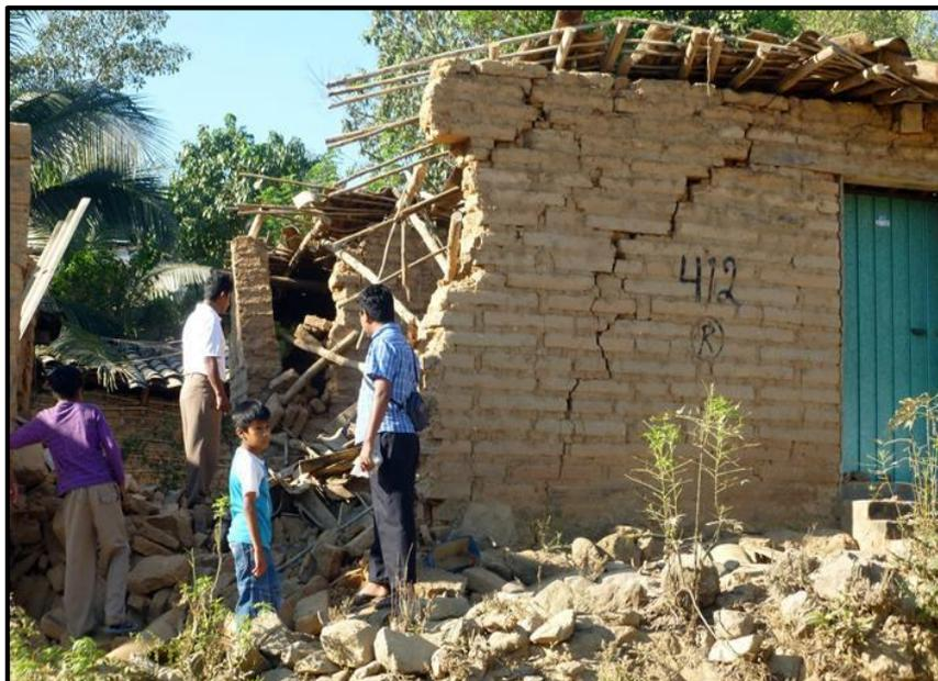
**Figura 95:** Vivienda colapsada por efecto de tormentas intensas.
