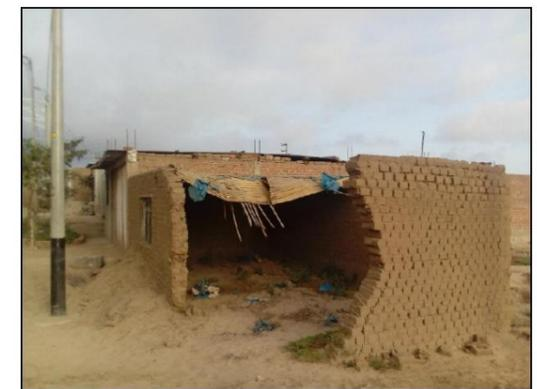
Figura 113: Colapso de Muros.
