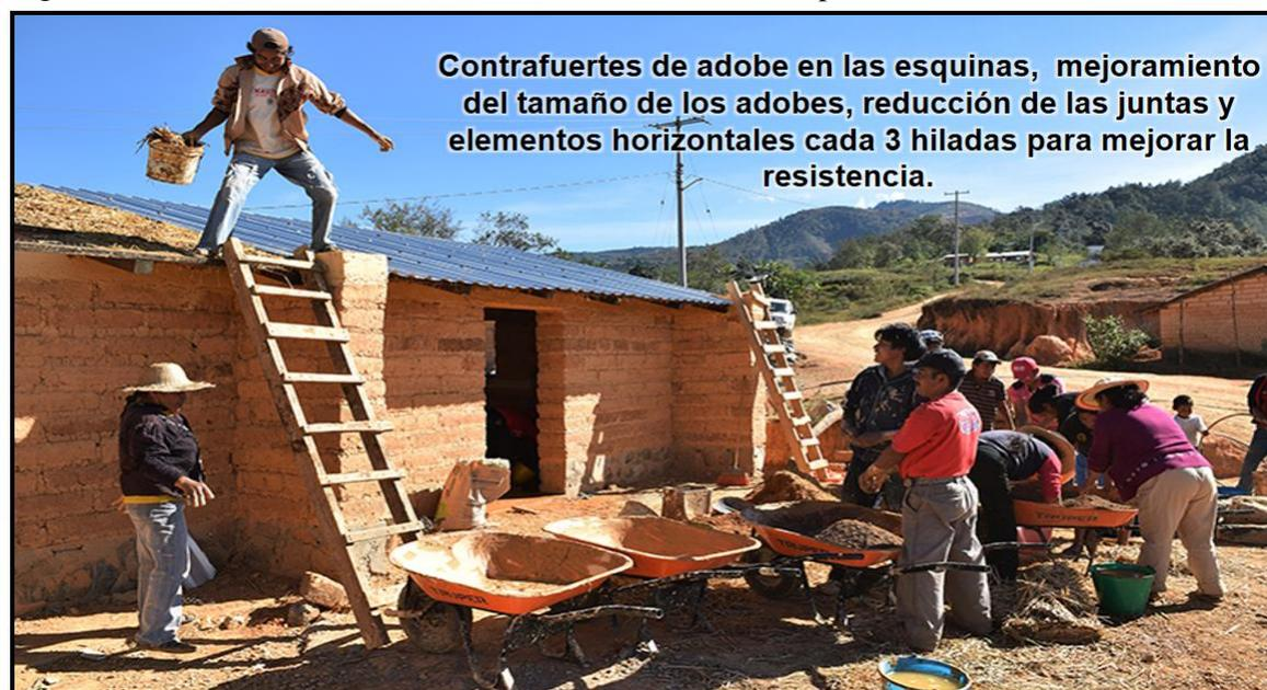
**Figura 99:** Utilización de contrafuertes -Fuente: web – Cooperación Comunitaria 2014
