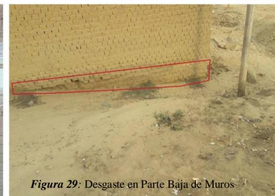
Figura 29: Desgaste en Parte Baja de Muros
