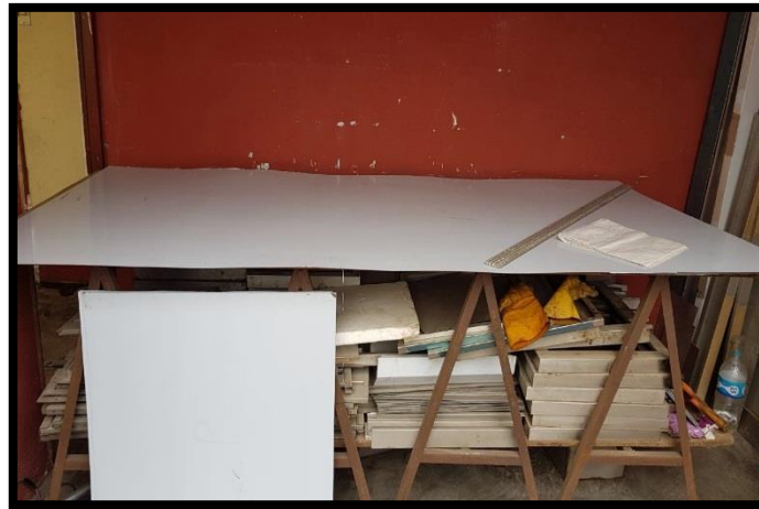
Figura 15 Trazado y piqueteado
