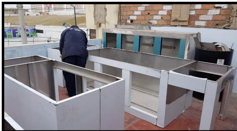
Figura 18 Armado del mueble con soldadura
