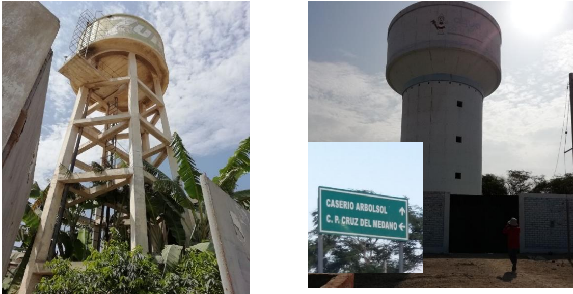
Figura 16 Reservorio para abastecimiento de la población (Cruz de Médano, Mórrope, Lambayeque)
