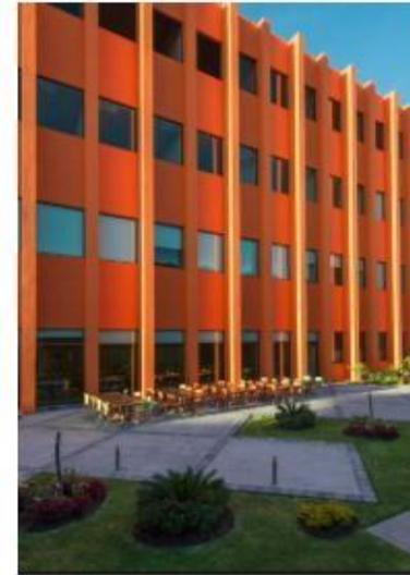
En la fachada, cada volumen juega con una inclinación diferente y tiene una serie de soportes verticales que funcionan como columnas estructurales eliminando la necesidad de columnas internas, así como la protección de exceso de iluminación solar.
