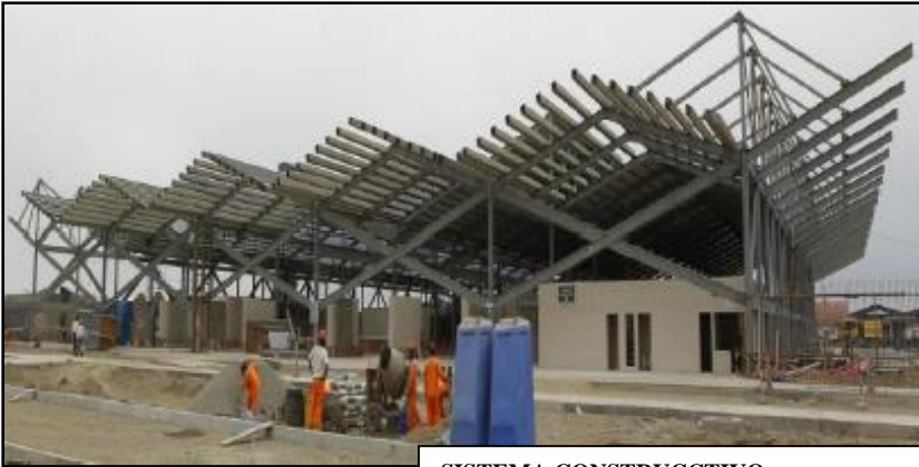
SISTEMA CONSTRUCTIVO, TIJERALES DE ACERO.
