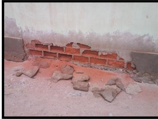
Figura 21: Erosión en muro de albañilería confinada de vivienda de 1 nivel.
