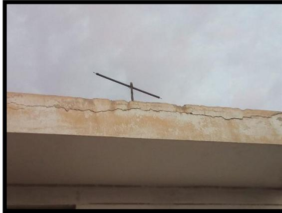
Figura 23: Fisura en la losa aligerada de la vivienda.
