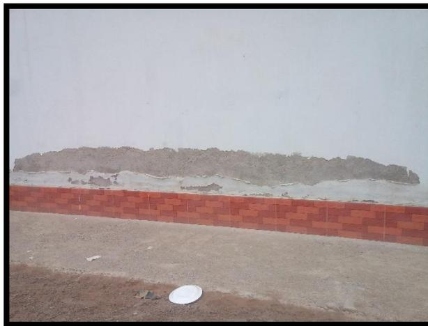
Figura 20: Humedad en muro portante de vivienda de 1 piso.
