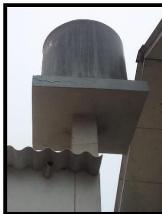
Figura 27: Tanque elevado apoyado por una losa sobre una columna.
