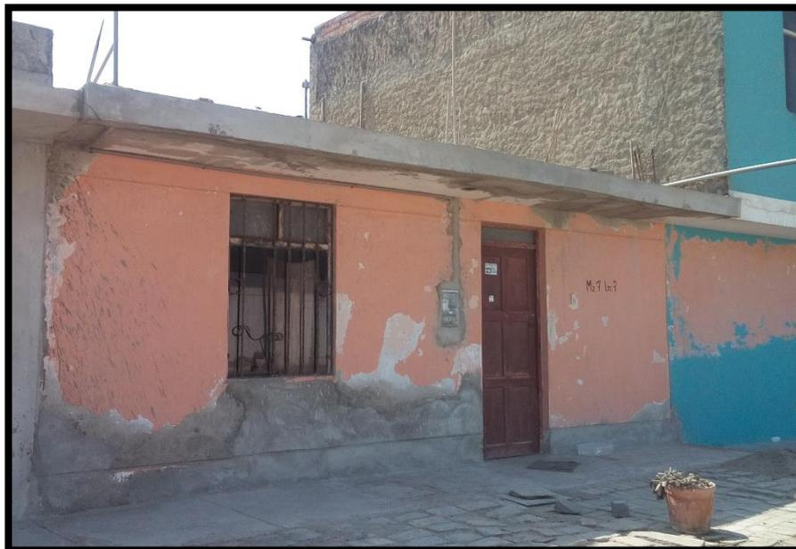
Figura 2: Vivienda de 1 nivel de albañilería confinada.
