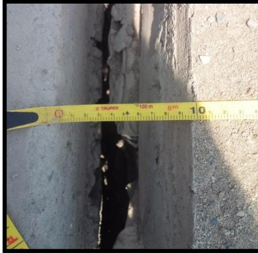
Figura 26: Junta Sísmica de 10 cm en vivienda de 1 piso.
