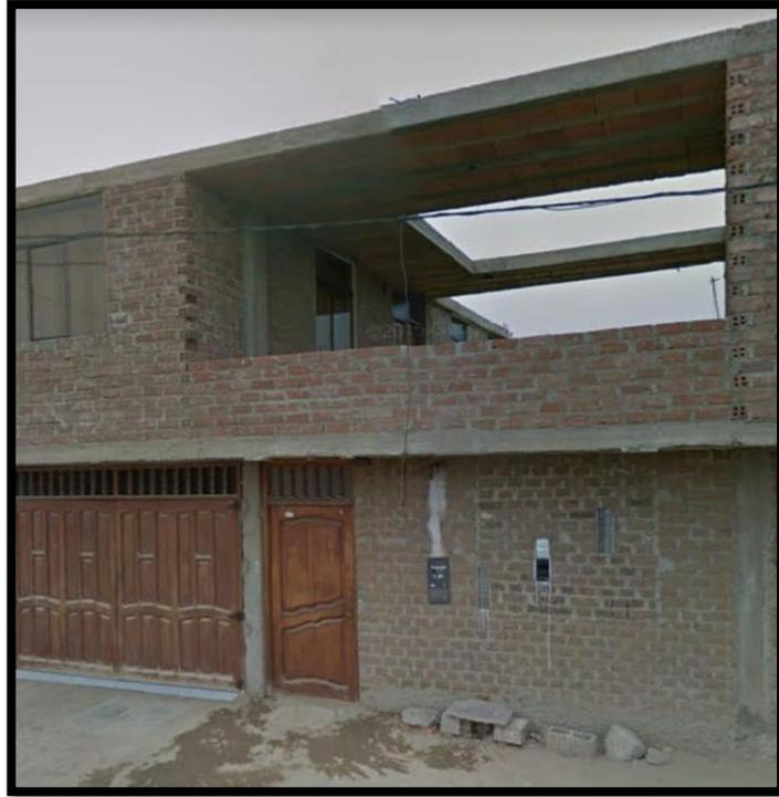
Figura 4: Vivienda de 2 niveles – 1 piso con muros de ladrillo crudo y el 2 piso con sistema estructural de albañilería.
