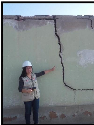
Figura 22: Grieta severa, indicador de colapso.
