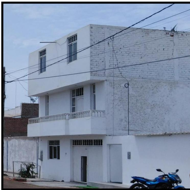
Figura 5: Vivivenda de 3 pisos de albañilería confinada.
