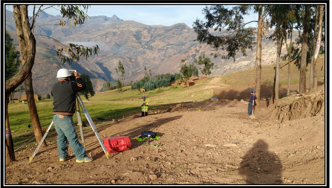
FIGURA N°10 Iniciando el levantamiento topográfico con estación total.
