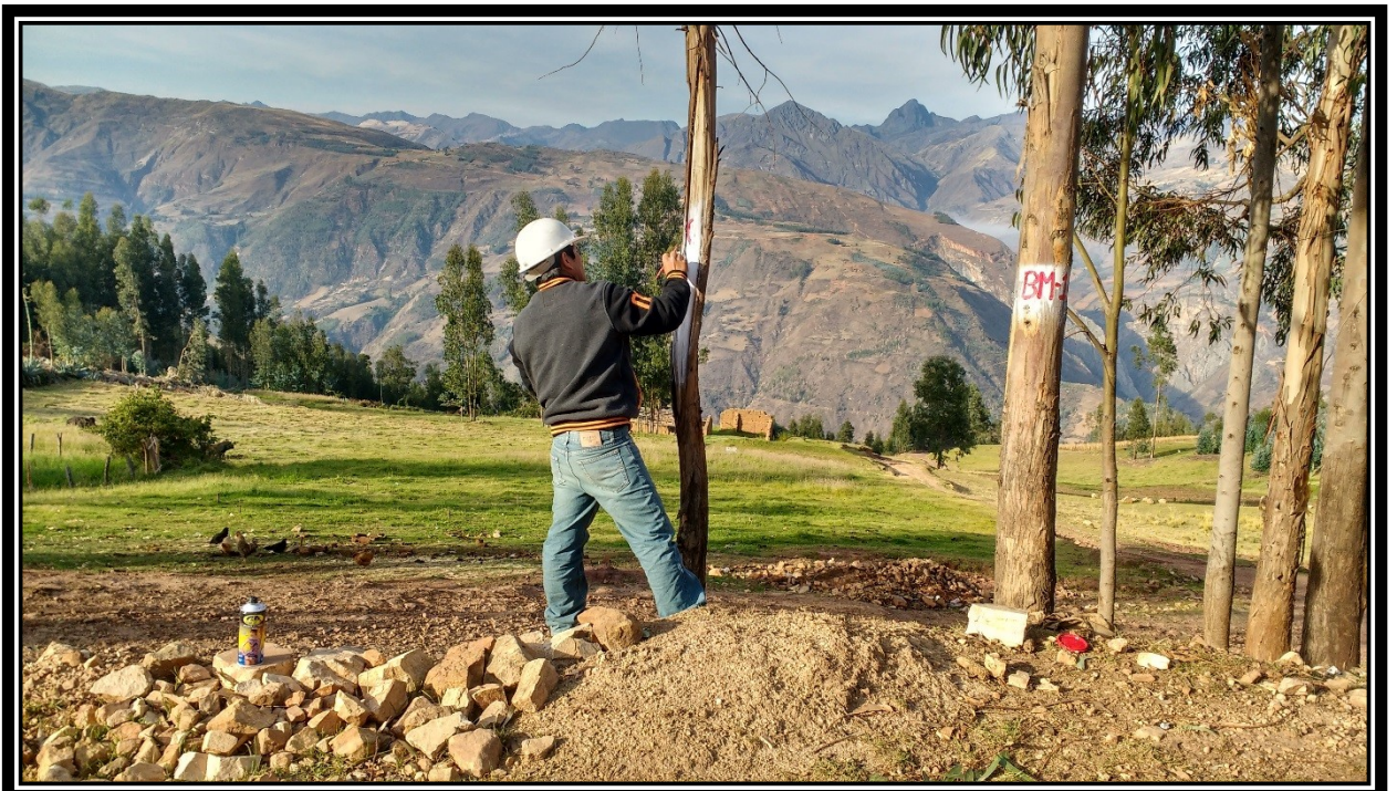
FIGURA N°7 Iniciando los estudios topografías con el punto BM y Km 0.0.
