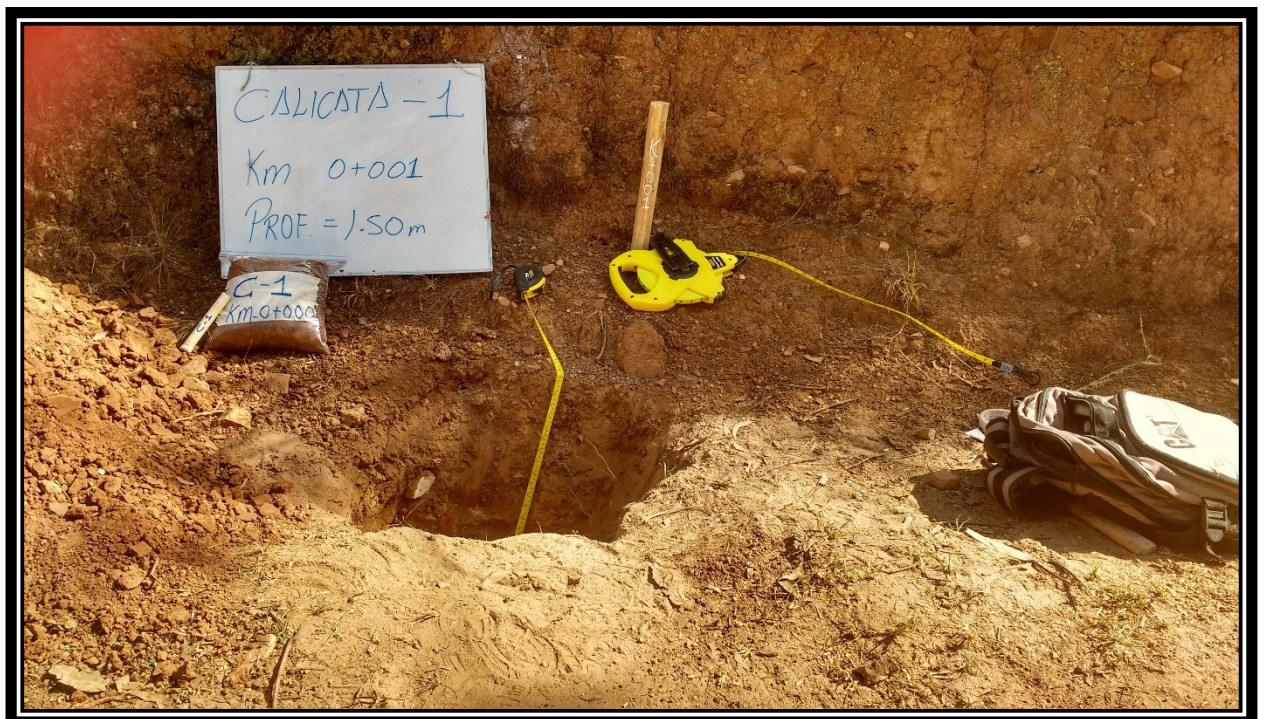
FIGURA N°11 Iniciando la muestra de calicata y estacado Km 1
