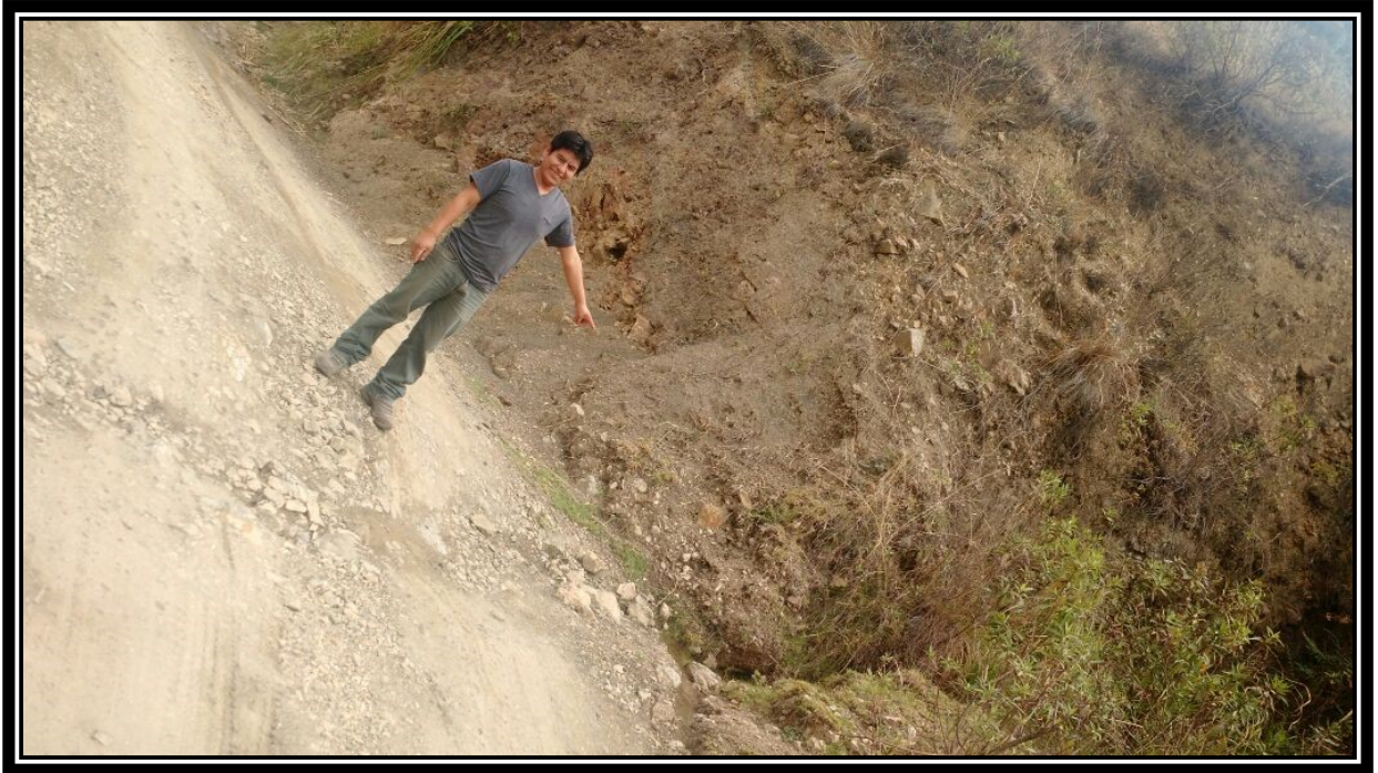
FIGURA N°3 La Falta de Baden en la Carretera.
