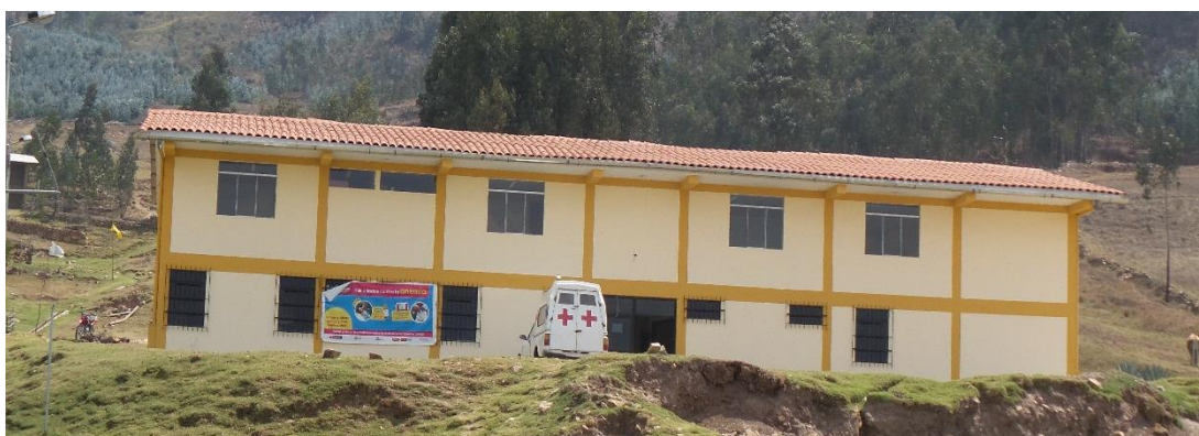
Imagen N° 07: Puesto de salud shiracorrall
