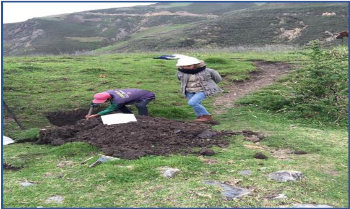
FOTOGRAFÍA N° 07: REALIZACIÓN DE LAS CALICATAS I
