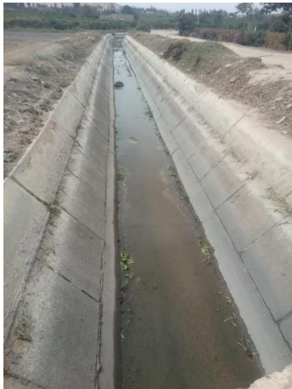
**FOTO N°08:** En la imagen se aprecia el canal totalmente vacío que nos permitió obtener media de la sección del canal, conocer el estado físico del canal como verificar las pendientes en cada punto de aforo.
