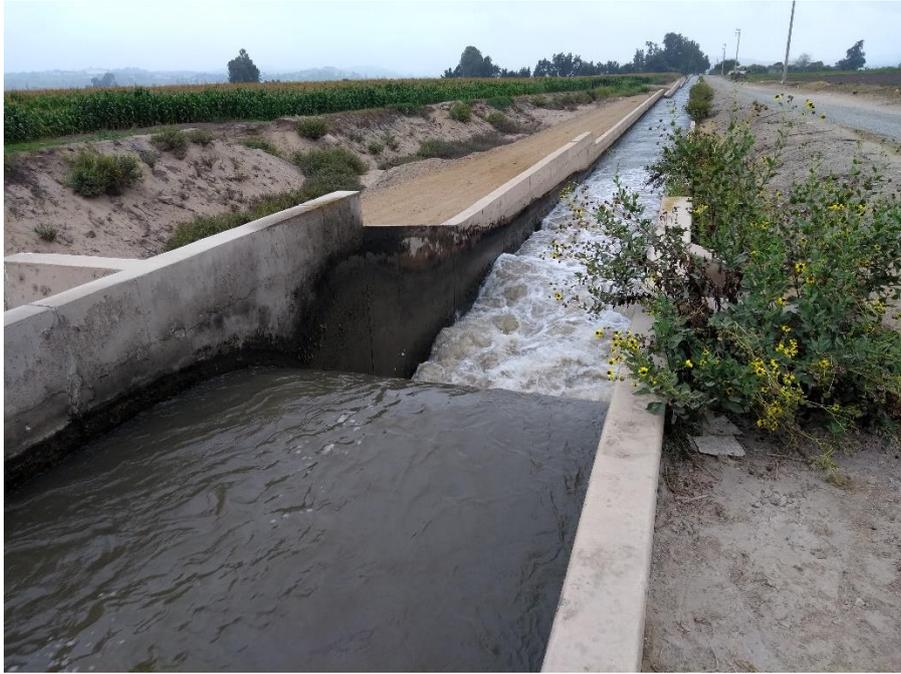
**FOTO N°03:** En la imagen se aprecia el recorrido de la rápida donde presenta una serie flujos turbulentos y resaltos hidráulicos, producto del diseño del canal, donde se muestra las progresivas y puentes peatonales.
