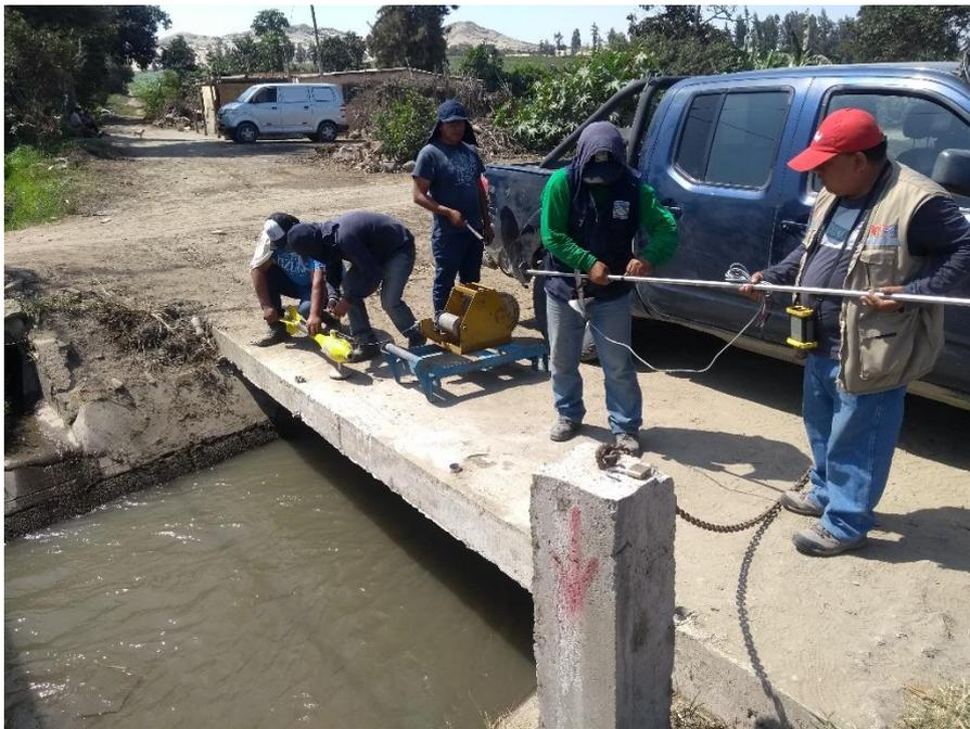
**FOTO N°07:** En la imagen se aprecia el desarrollo del tercer aforo en la progresiva 7+560 donde ya determinado los puntos para medir las velocidades y las profundidades para ingresar el correntómetro se procedió a medir las velocidades con un equipo electrónico el cual va conectado al correntómetro para medir el número de revoluciones por 30 segundo. Las mediciones de revoluciones se realizaron por tres veces en cada punto.
