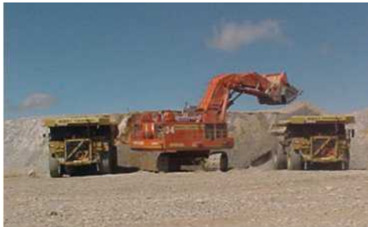
Figura 17: Pala hidráulica trabajando con dos camiones simultáneamente
