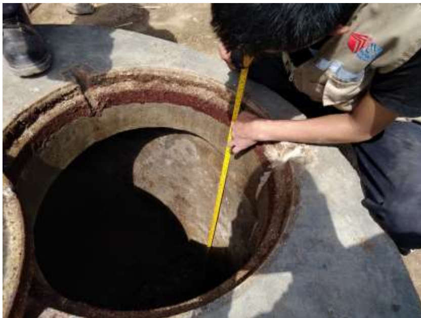
Imagen N° 12: Medición de la altura de los buzones.
