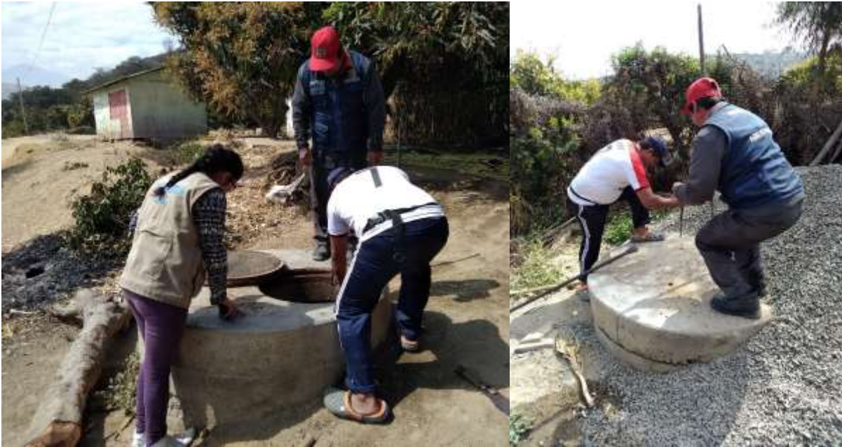
Imagen N° 11: Apertura de la tapa de los buzones para realizar la inspección.
