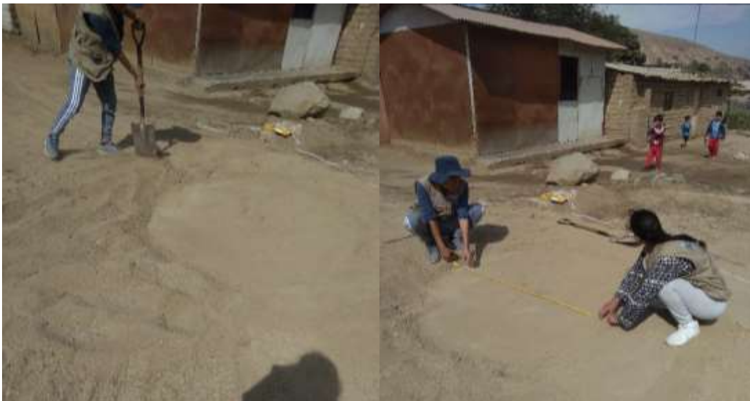
Imagen N° 08: Medición del diámetro exterior de los buzones.
