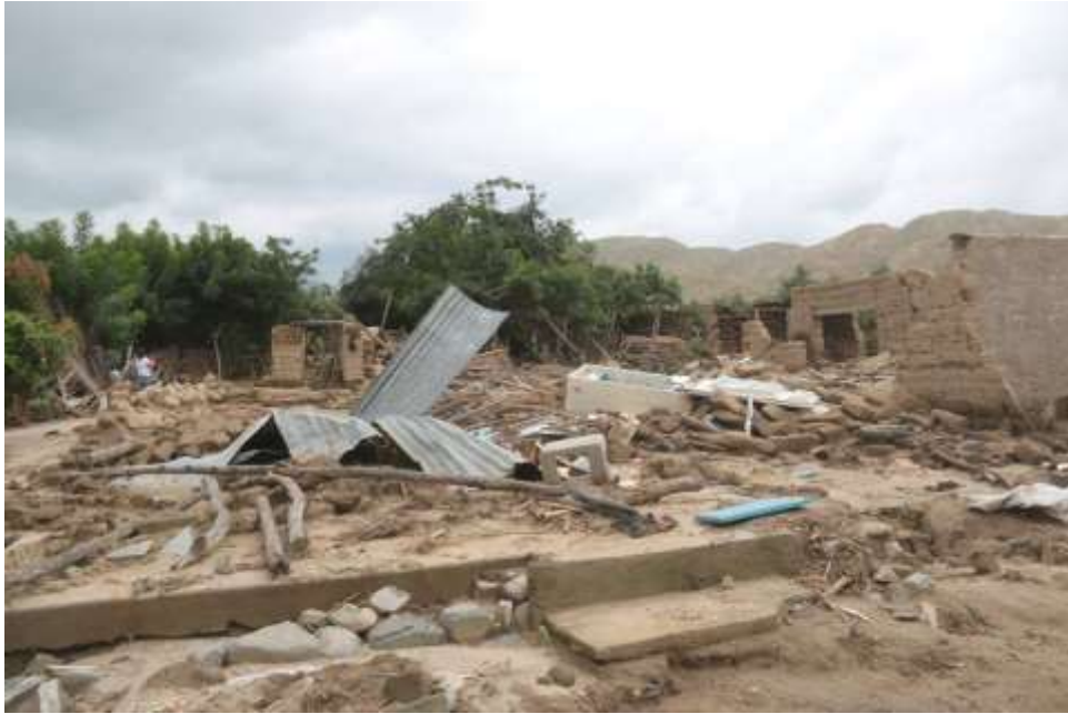
Imagen N° 01: Viviendas colapsadas debido al huaico.
