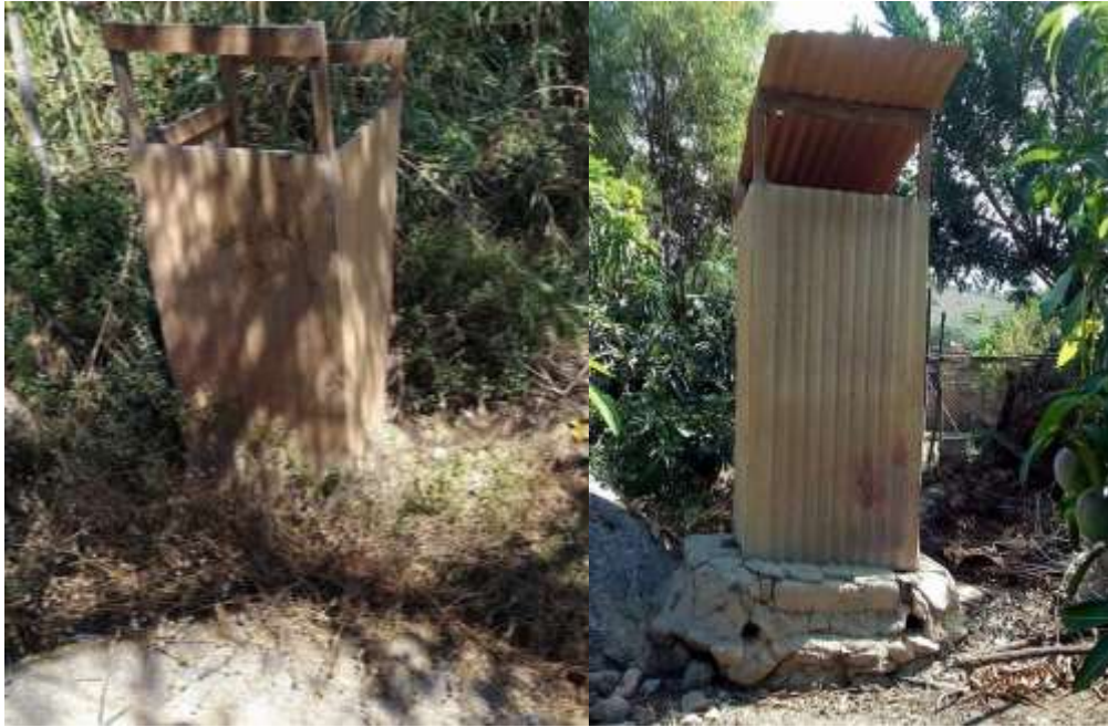
Imagen N° 07: Letrinas artesanales hechas por los pobladores que no cuentan con red de alcantarillado.
