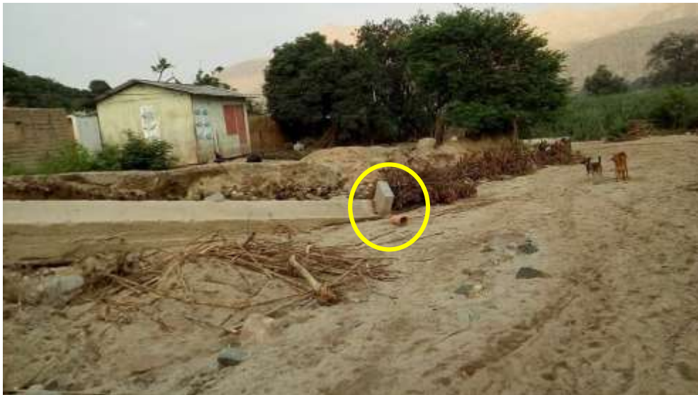
Imagen N° 02: Tuberías de red de alcantarillado removida debido al huaico.
