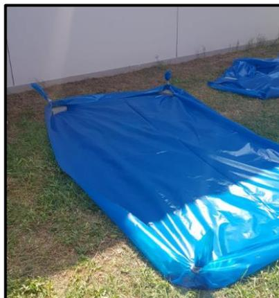
Figura 25 Plástico como base para la preparación de la mezcla
