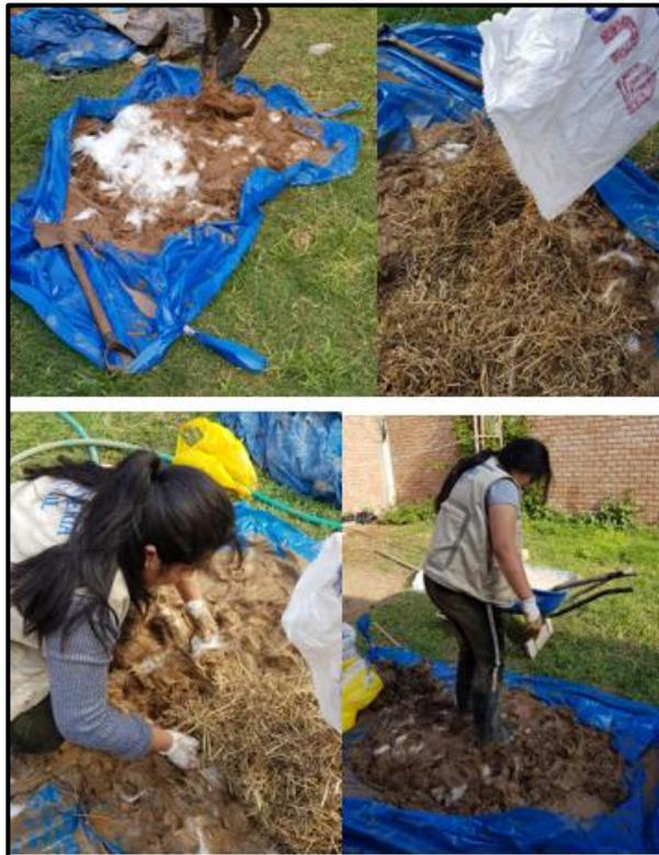
Figura 29. Elaboración de mezcla con paja y fibra de vidrio tipo E
