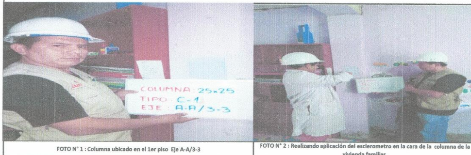
FOTO N° 1 : Columna ubicado en el 1er piso Eje A-A/3-3
