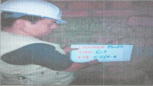
FOTO N° 1 : Columna ubicado en el 2do piso Eje C-C/6-6
