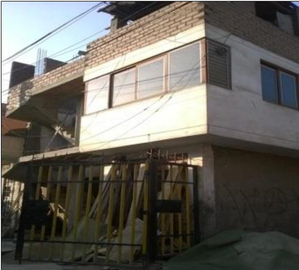
Figura 3: independizando al segundo, tercer piso. Fuente: elaboración propia.
