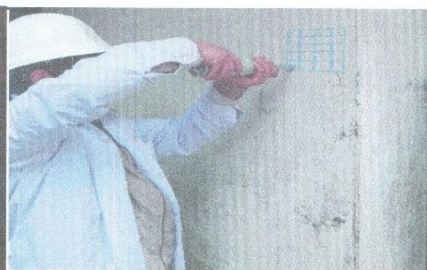
FOTO N° 2 : Realizando aplicación del esclerometro en la cara de la columna de la vivienda familiar.
