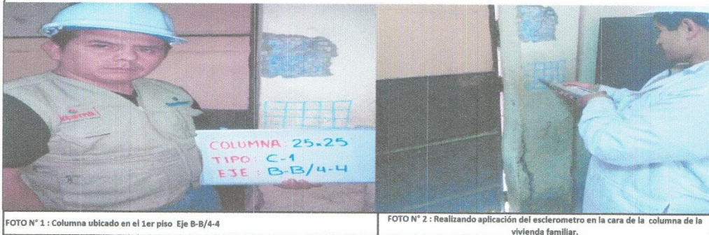
FOTO N° 1 : Columna ubicado en el 1er piso Eje B-B/4-4
