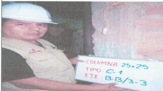
FOTO N° 1 : Columna ubicado en el 2do piso Eje B-B/3-3
