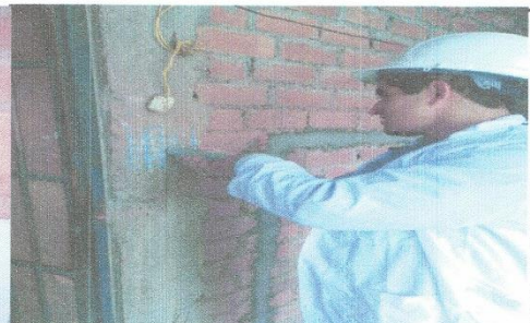
FOTO N° 2 : Realizando aplicación del esclerometro en la cara de la columna de la vivienda familiar.
