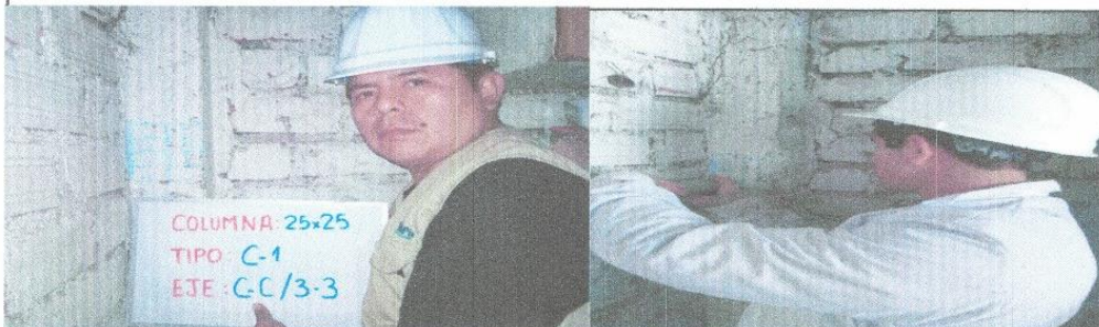
FOTO N° 1 : Columna ubicado en el 2do piso Eje C-C/3-3
