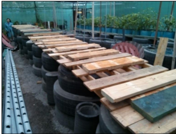
Ilustración 14 Preparación de la base de los sistemas de recirculación acuapónicos 1 y 2.
