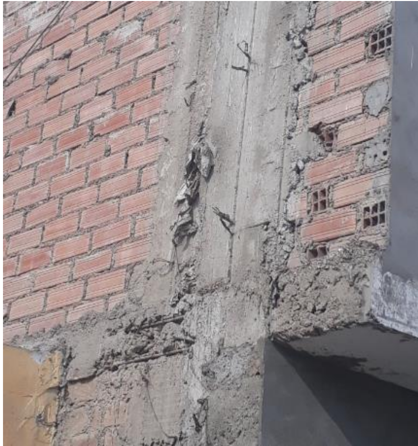
Fig. 3.14 Exposición de aceros de refuerzos. (Fuente: Propia.)
