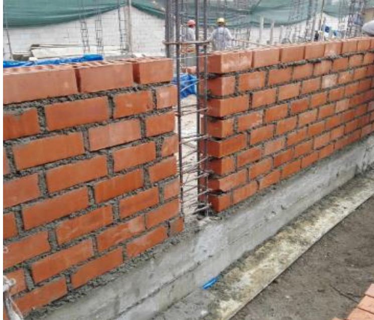
Fíg-1.6. Albañilería confinada (Fuente elaboración propia)
