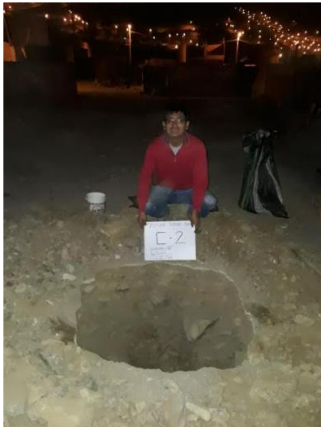
Fig. 3.18 Calicata-2 (Fuente: Propia.)
