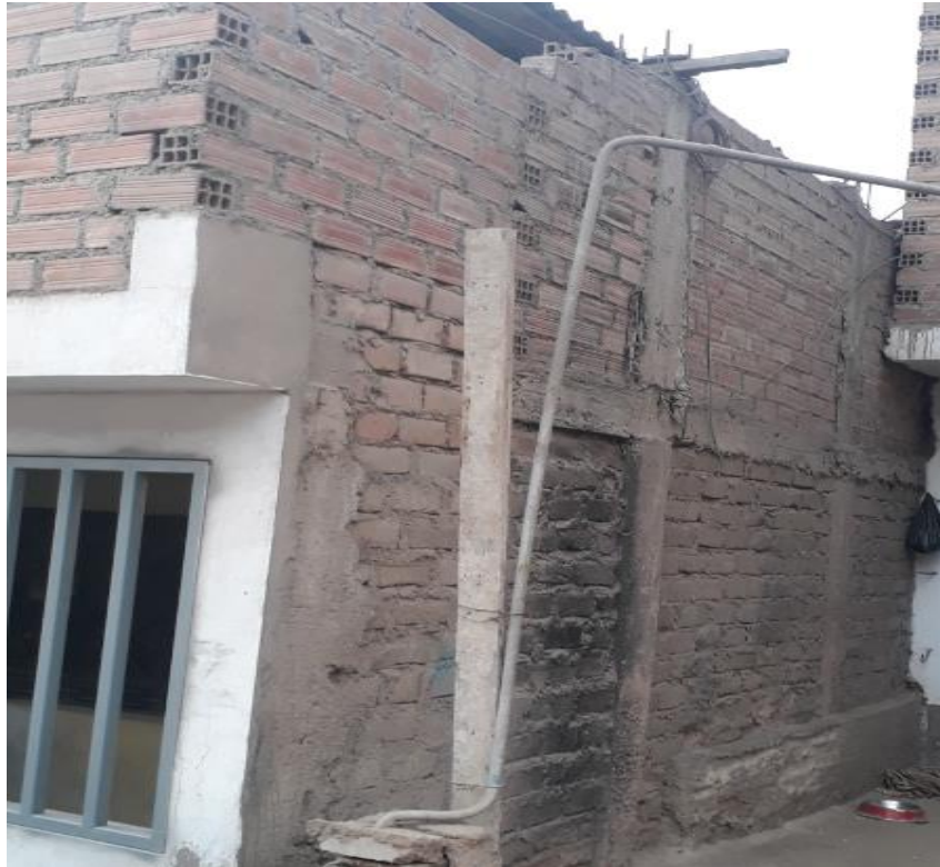
Fig. 3.16 Junta fría. (Fuente: Propia.)
