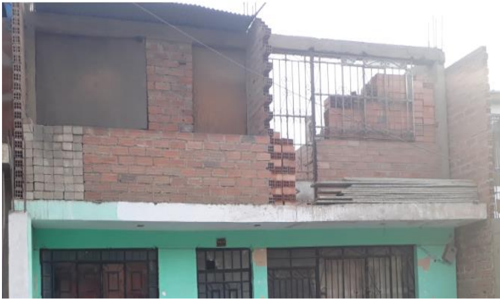
Fig. 3.9 Vivienda con densidad de muros altos (Fuente: Propia.)
