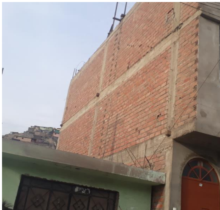
Fig. 3.4 Viviendas error de simetría. (Fuente: Propia.)
