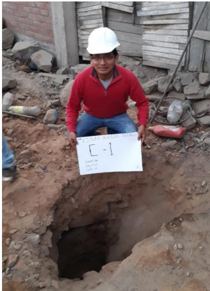
Fig. 3.17 Calicata-1 (Fuente: Propia.)
