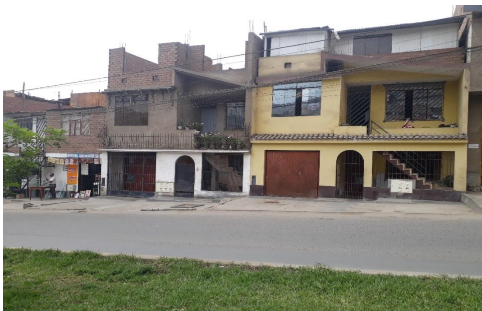
Fig.1.9 – Vista de las viviendas del Asentamiento humano Juan Pablo II. San Juan de Lurigancho (Fuente: Elaboración propia)
