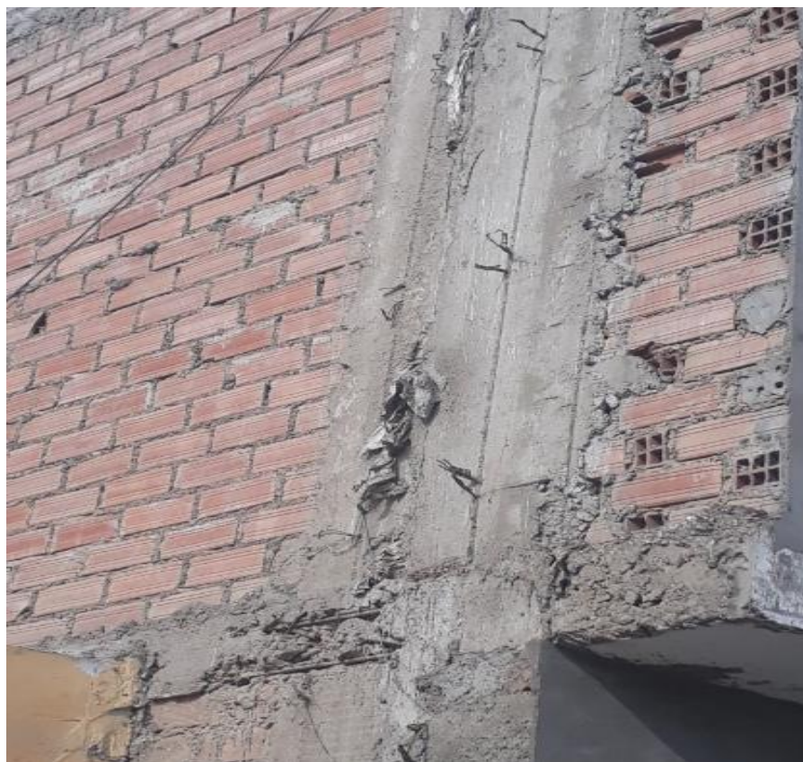
Fig. 3.12 Vivienda con muro portante con ladrillo pandereta (Fuente: Propia.)
