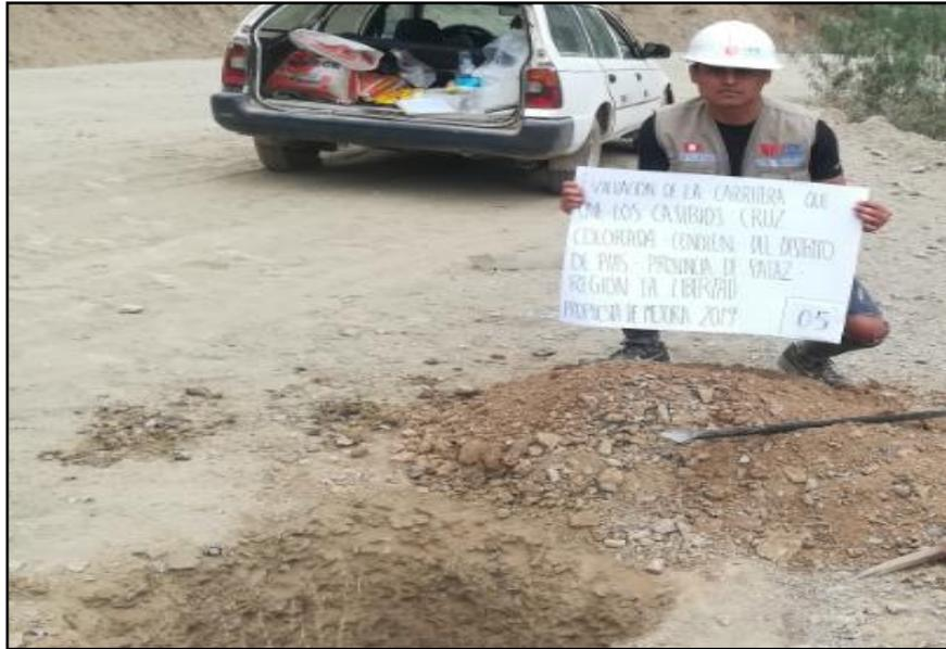
**Foto 03:** Excavación de calicata C-5 progresiva 2+000 km
