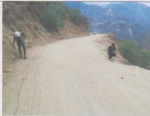
FOTO N° 05: Realizando la medición del ancho de la vía en la progresiva Km 2+000
