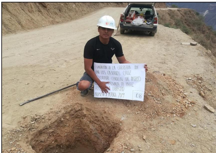
**Foto 04:** Excavación de calicata C-08 progresiva 3+500 km
