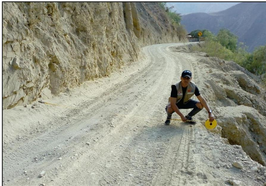
**Foto 04:** Medición ancho de vía para implementación de obras de arte.
