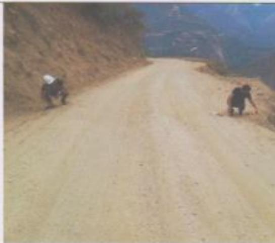
FOTO N° 09: Realizando la medición del ancho de la calzada de la vía en la progresiva Km 4+000
