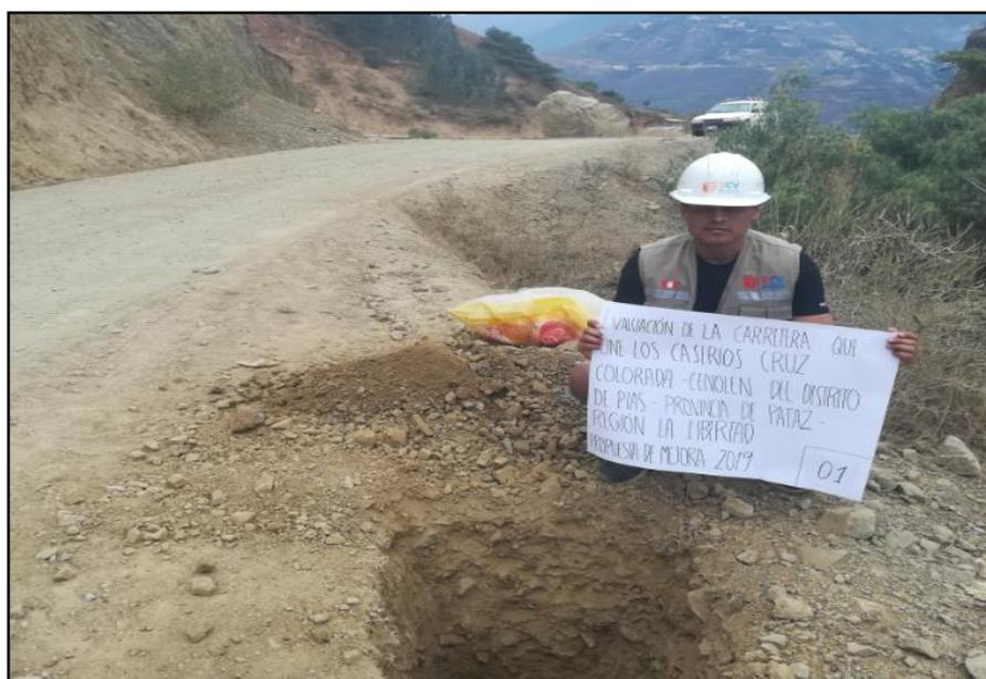
**Foto 01:** Excavación calicata C-1 progresiva 0+000 km
