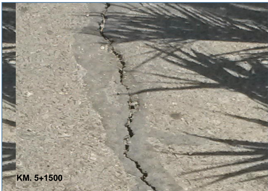
Figura 47. Grietas Longitudinales.
