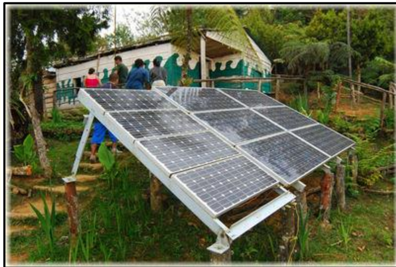
Sistema fotovoltaico autónomo
