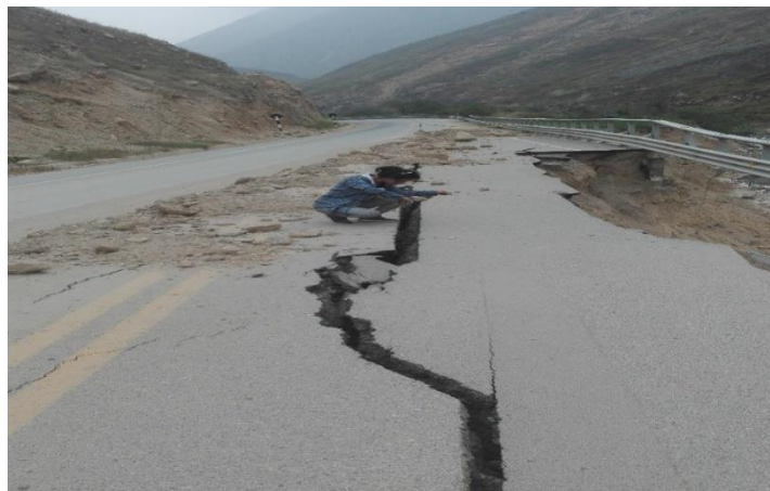
Imagen N°5: Fallas transversales
