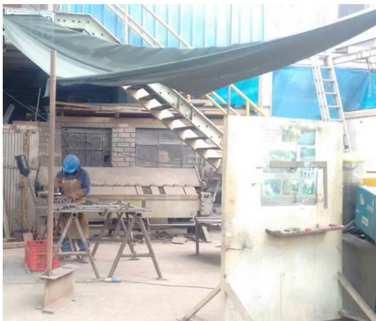
Figura 20. Armado. En el área de armado se realizaron mediciones paralelas al de las oficinas administrativas del nivel superior. Adaptación propia, 2017.
