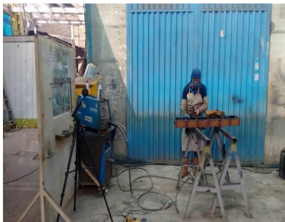
Figura 17. Soldadura 2. Se aprecia esmerilado y corte con amoladora. Adaptación propia, 2017.
