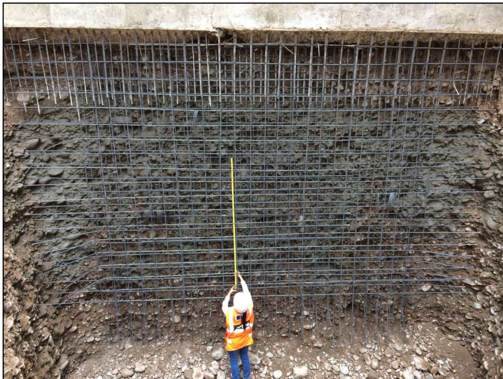
Foto 05: Se puede apreciar el armado de la malla de acero
