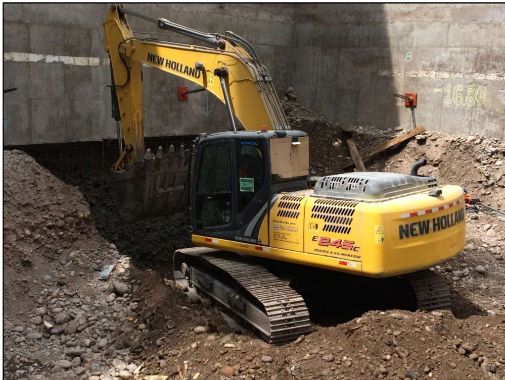
Foto 03: Aquí se aprecia que la máquina excavadora apertura la banqueta con mayor comodidad que la imagen anterior
