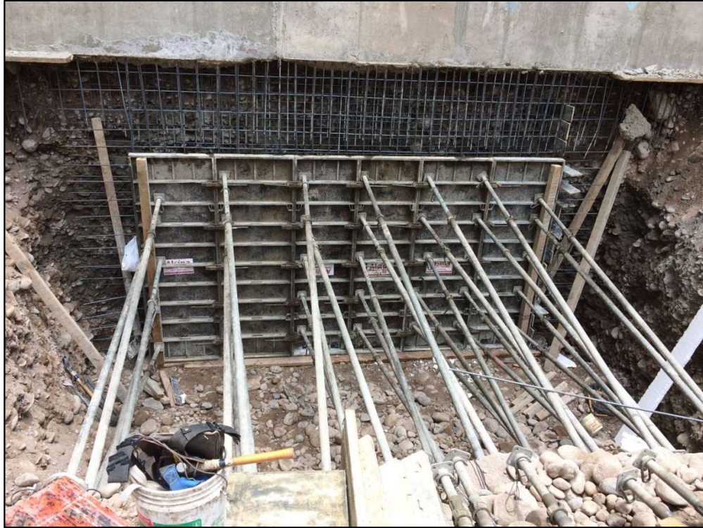
Foto 06: En la imagen apreciamos el encofrado del muro
