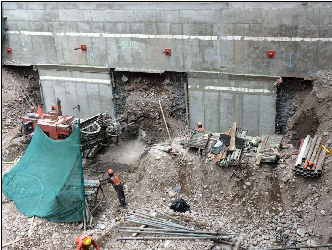
Foto 01: En esta imagen se aprecia la perforación que se aplica al talud para colocar el anclaje
