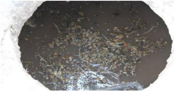
*Figura N°08.* Material causante de la obstrucción (Residuos de avícola).
