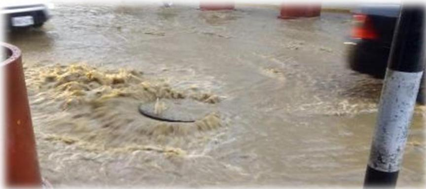
*Figura N° 23. Colapso de buzón en la Av. Luzuriaga.*
