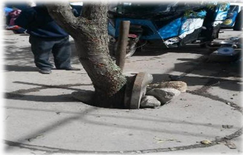
*Figura N°09.* Obstrucción del alcantarillado debido a costumbres de los pobladores.
