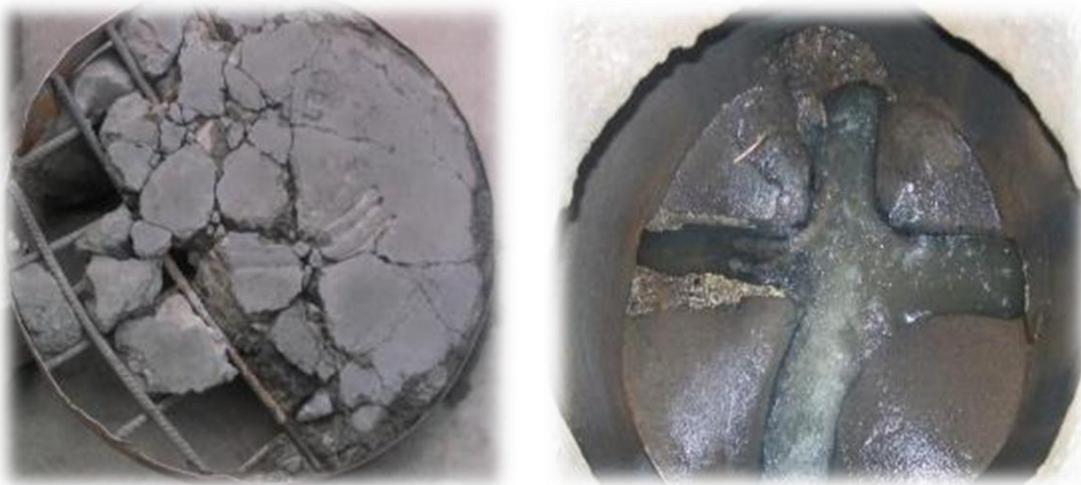
*Figura N°06.* Desgaste en elementos del alcantarillado sanitario.
