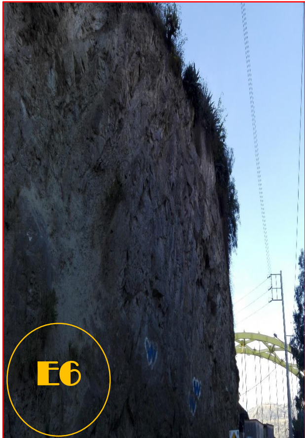
Fotografía 11: Sectorización por niveles de vulnerabilidad, características físicas y mecánicas del macizo rocoso, se visualiza la estación E6, se visualiza el macizo rocoso disgregado por diaclasas continuas y con una falla por volcamiento.
