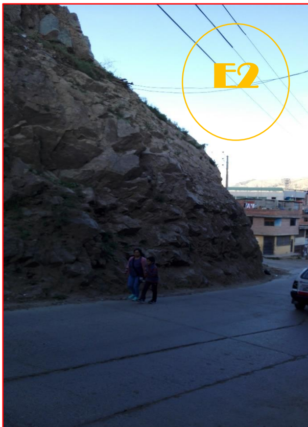
Fotografía 06: Sectorización por niveles de vulnerabilidad, características físicas y mecánicas del macizo rocoso, se visualiza la estación E2, identificada con una falla por volcamiento.
