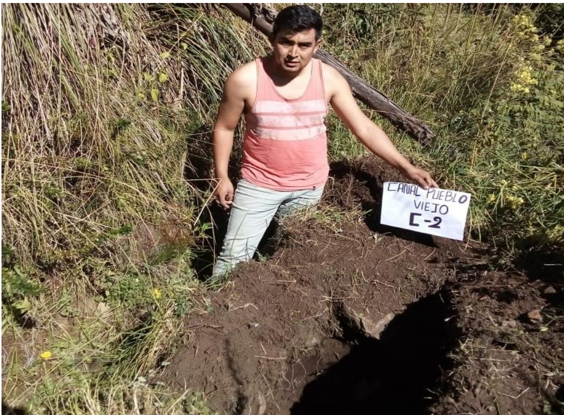
Estudio de mecánica de suelos: Calicata 2
