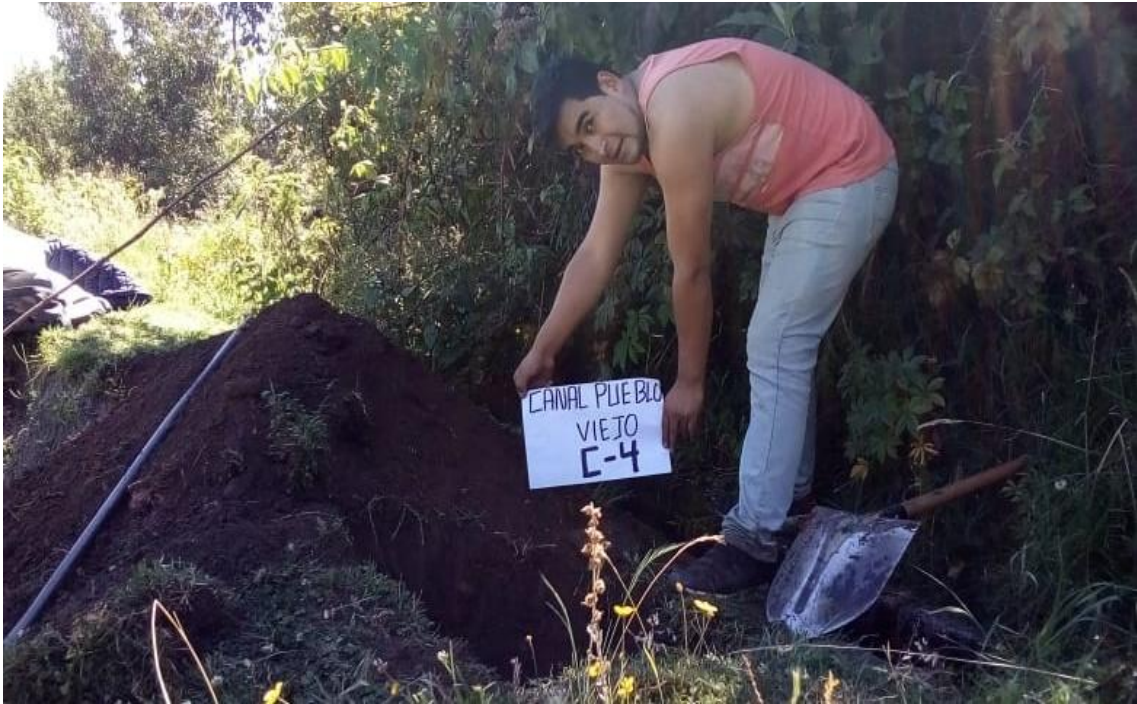
Estudio de mecánica de suelos: Calicata 4
