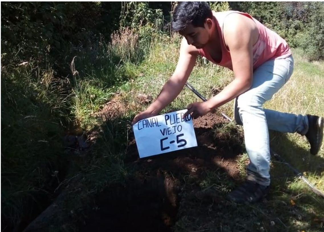
Estudio de mecánica de suelos: Calicata 5
