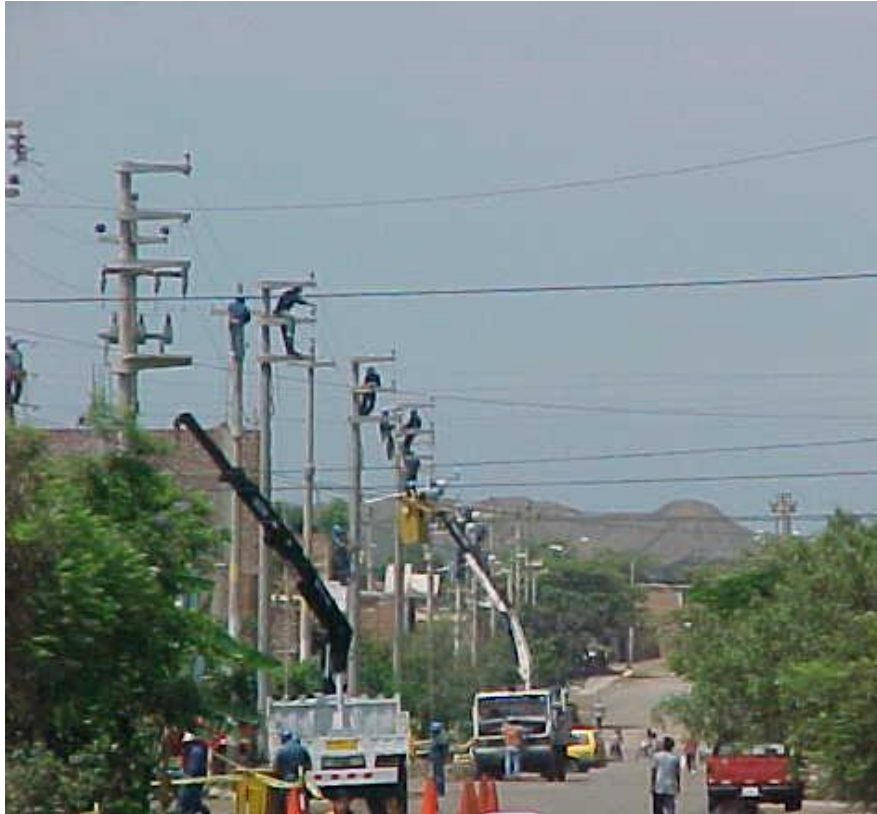
Figura 1.10: Trabajos ejecutados sin energía eléctrica
