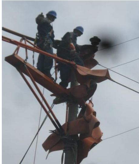
Figura 1.16: Trabajos con plataforma
