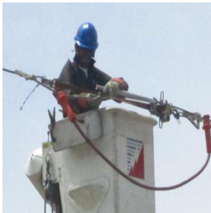
Figura 1.19: Reparación de línea
