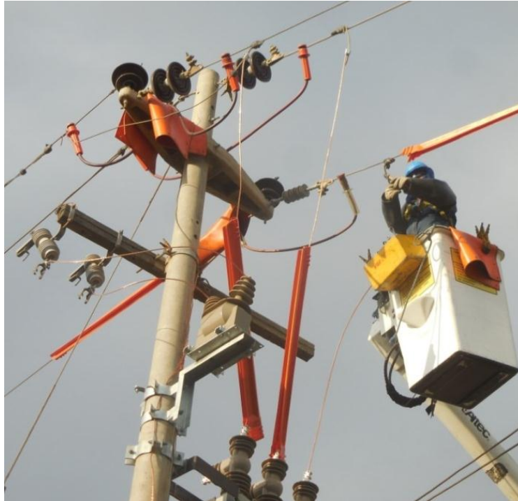
Figura 3.12: Conexionado de equipo recloser
