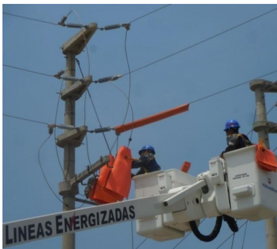
Figura 1.14: Cambio de seccionador cut Out
