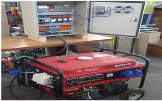
*Figura 8.* Suministro y montaje de tableros de transferencia.
