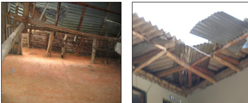
*Figura 3.* Techos deteriorados de las actuales instalaciones del edificio municipal.
