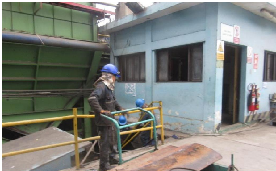
Anexo 18: Señalización de puntos contra incendios.
