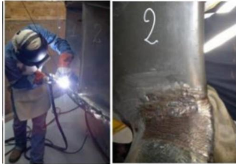
Figura 32: Proceso de soldadura del rodete Francis.
