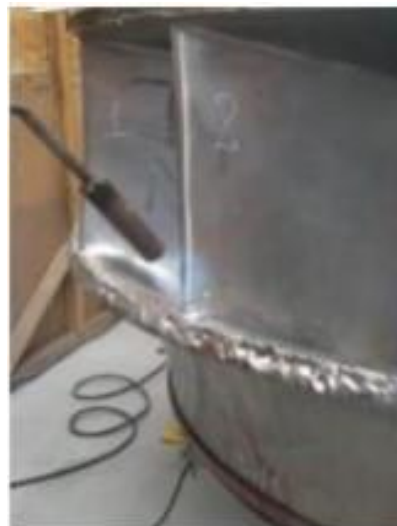
Figura 27: Precalentamiento del material base antes de soldar a una temperatura de 120°C.
